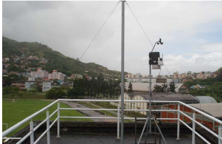
Figura 3.6 – Base de medição de iluminação natural, cobertura do prédio.
