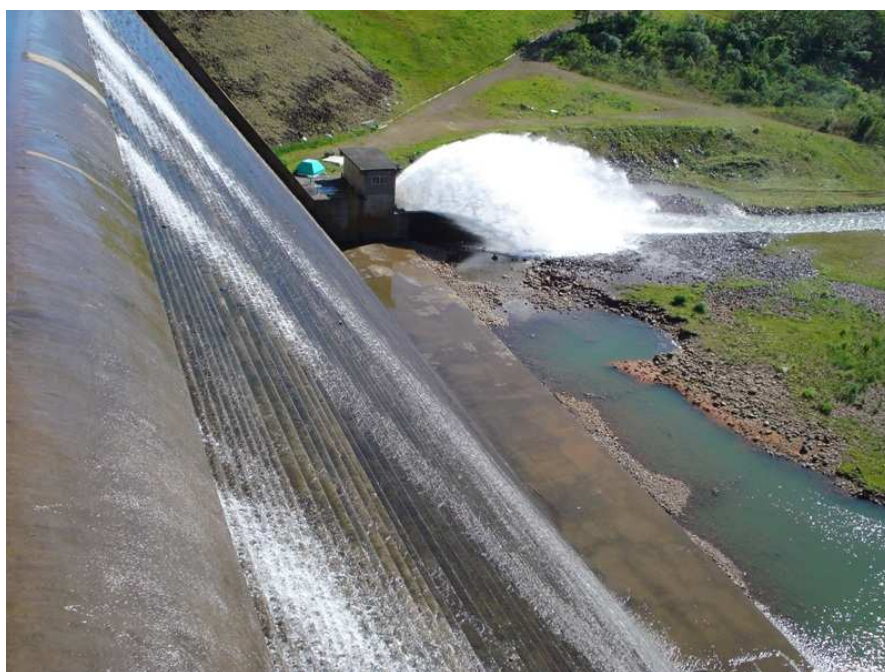
Barragem do Rio São Bento em 31/10/2008
