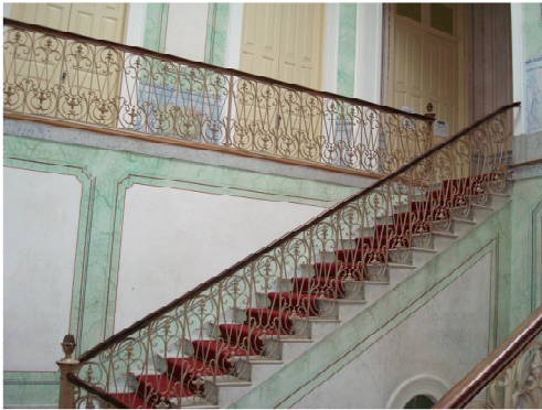
Figura 26 – Revestimento das paredes em escaiola na circulação vertical – escada principal
