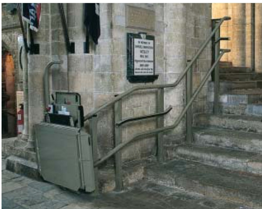
Figura 70 – Plataforma elevatória inserida junto à escada de acesso principal. Disponível em: EH_EasyAccess_2004.pdf . Acesso: 08/06/2009
