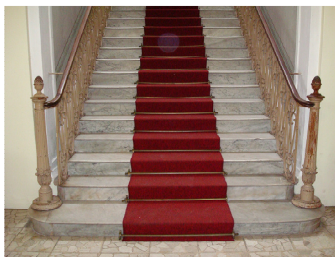
Figura 25 – Escada principal interna, também com revestimento em mármore
