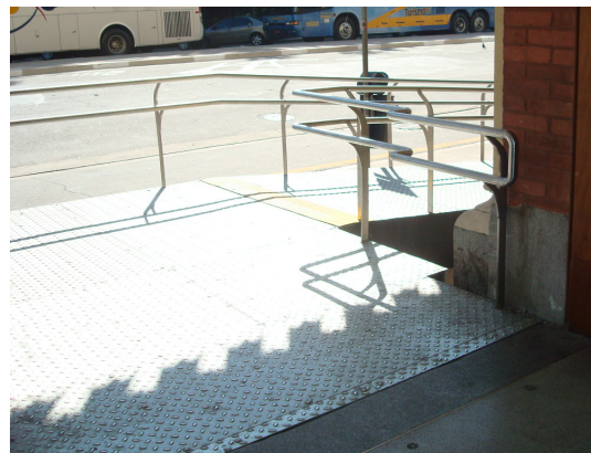
Figura 79 – Inserção de corrimão em duas alturas e com cantos curvados no acesso alternativo à Estação da Luz. Estação da Luz, São Paulo-SP.
