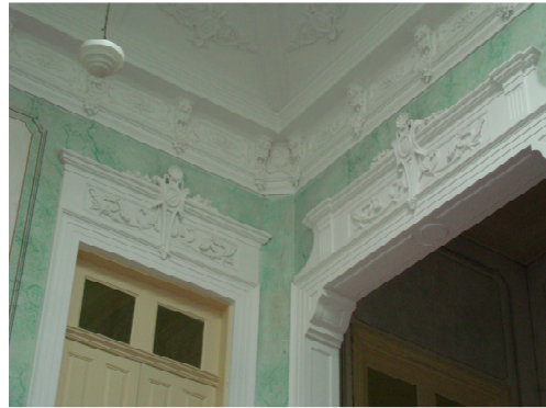
Figura 27 – Afrescos em gesso tanto na parte superior das portas internas quanto no teto do segundo pavimento
