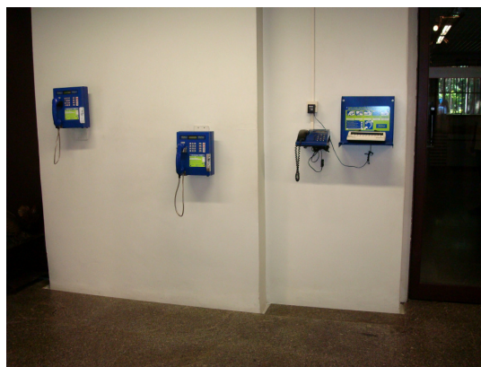
Figura 83 – Instalação de terminais telefônicos em diferentes alturas e terminal telefônico para surdos. Pinacoteca do Estado, São Paulo-SP.
