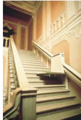
Figura 75 – Cadeira elevatória inserida junto ao corrimão da escada principal. Fonte não localizada.
