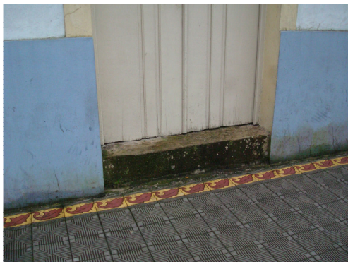
Figura 20 – Novo ladrilho hidráulico instalado nas calçadas, semelhante ao antigo
