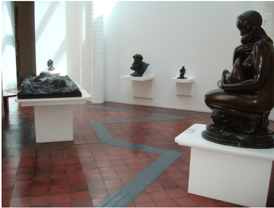
Figura 48 – Piso tátil alerta e direcional identificam o percurso para a pessoa com restrição visual na exposição de arte. Pinacoteca do Estado, São Paulo – SP.
