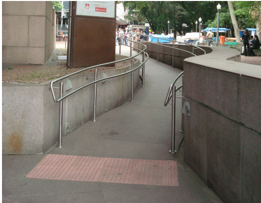
Figura 36 – Inserção de piso tátil alerta no início e término da rampa. Estação da Luz, São Paulo – SP.
