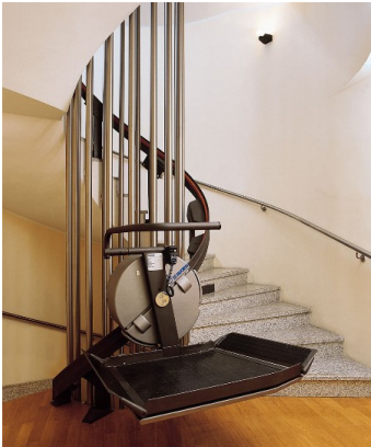
Figura 74 – Plataforma elevatória inserida em escada. Disponível em: http://www.specialcare.pt/images/p020_1_00.jpg . Acesso: 08/06/2009.
