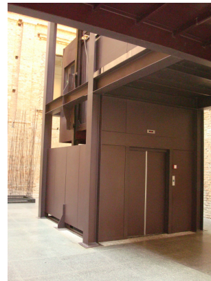
Figura 77 – Caixa do elevador, em chapa metálica, identificando a intervenção. Pinacoteca do Estado, São Paulo – SP.
