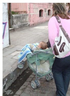
Figura 04 – Mesmo sem ter deficiência, a mãe com carrinho de bebê tem dificuldades ao subir a calçada devido à ausência de guia rebaixada.
