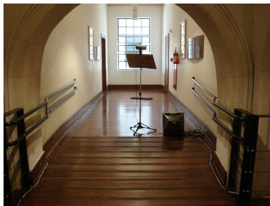
Figura 85 – Instalação de corrimão em duas alturas em material contemporâneo, destacado do contexto, nas paredes. Sala São Paulo, São Paulo – SP.
