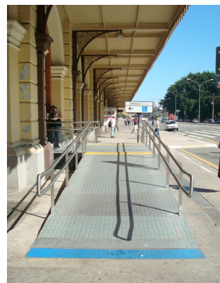
Figura 67 – Rampa inserida no acesso alternativo à Estação da Luz com piso antiderrapante (chapa metálica rugosa). Estação da Luz, São Paulo-SP.
