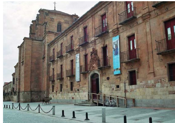
Figura 71 – Rampa em madeira inserida junto da escada de acesso principal à edificação. Salamanca, Espanha. Foto: J. A. Junca Ubierna
