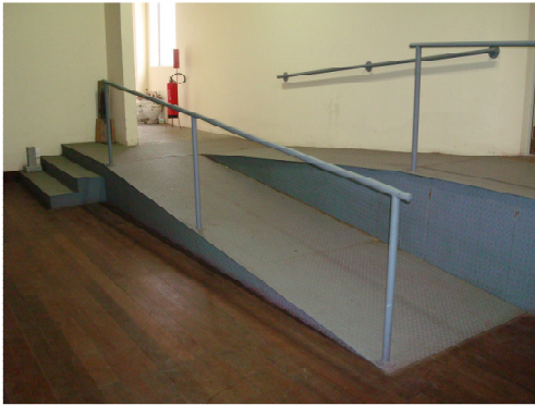
Figura 18 – Rampa inserida no interior do edifício, no acesso para pessoas com deficiências
