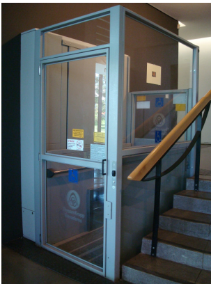
Figura 76 – Inserção de plataforma elevatória ao lado da escada principal, possibilitando uso de todos os indivíduos. Museu de Arte Moderna, São Paulo – SP.
