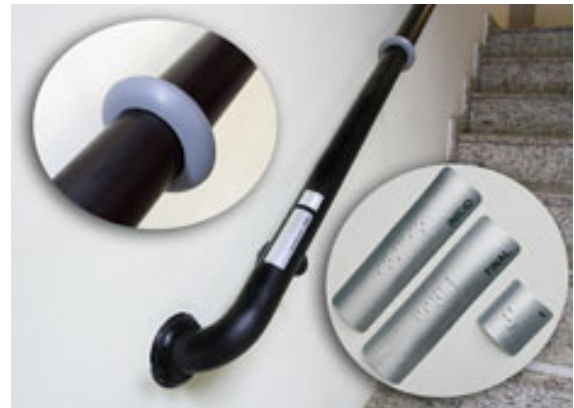
Figura 57 – Placa com informação tátil inserida no corrimão da escada. Disponível em: http://www.seton.com.br/aanew/produtos/imgg/A455.jpg . Acesso: 08/06/2009.
