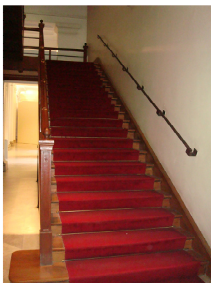
Figura 84 – Instalação de corrimão na parede adjacente da escada de forma contemporânea, identificando a intervenção. Pinacoteca do Estado, São Paulo – SP.
