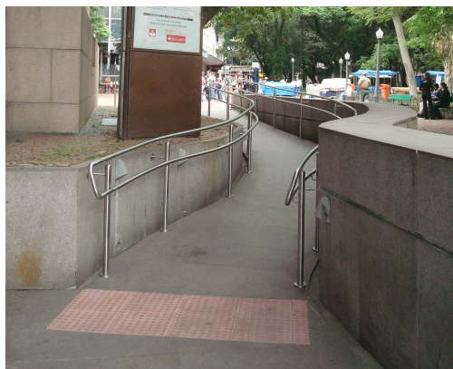
Figura 66 – Rampa inserida no acesso alternativo à edificação. Santander Cultural, Porto Alegre, – RS.
