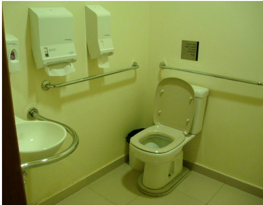
Figura 88 – Barras de apoio e disposição dos equipamentos permitem o uso do sanitário por pessoas com deficiências. Sala São Paulo, São Paulo – SP.
