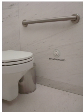
Figura 62 – Instalação de botão de pânico junto à bacia sanitária para acionamento em caso de queda. Museu Iberê Camargo, Porto Alegre – RS.
