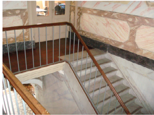
Figura 19 – Paredes do 2º pavimento, recuperadas, também tem revestimento em escaiola
