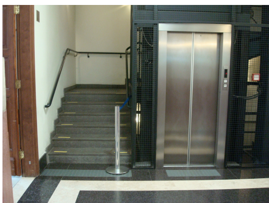
Figura 86 – Instalação de corrimão na parede adjacente da escada de forma contemporânea, identificando a intervenção. Sala São Paulo, São Paulo – SP.
