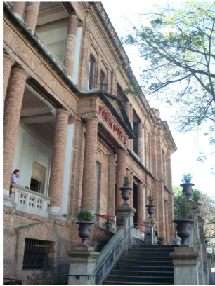
Figura 30 – O prédio, construído para sediar o Liceu de Artes e Ofícios, recebeu letreiro na fachada com seu novo uso. Pinacoteca do Estado, São Paulo – SP.
