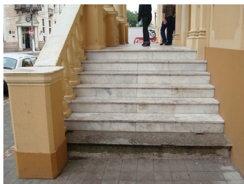
Figura 24 – Escada externa, na fachada principal, com revestimento em mármore
