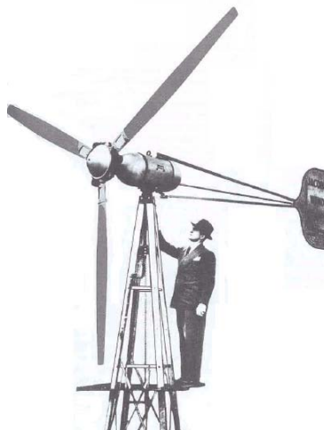
Figura 1.2 – Turbina eólica de Jacobs usada no carregamento de baterias. Fonte: [8].
