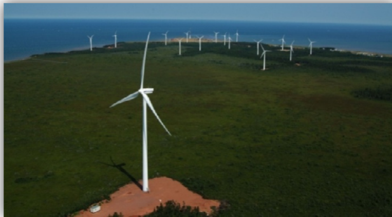
Figura 1.9 – Parque on-shore na Ilha Prince Edward, no Canadá, com turbinas V90 de 3.0 MW, da Vestas. Fonte: http://www.vestas.com . Acesso em: 18 fev. 2008.
