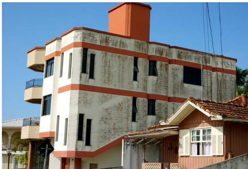
Figura 1: Exemplo de fachada sul biodeteriorada, em Capoeiras, Florianópolis.
