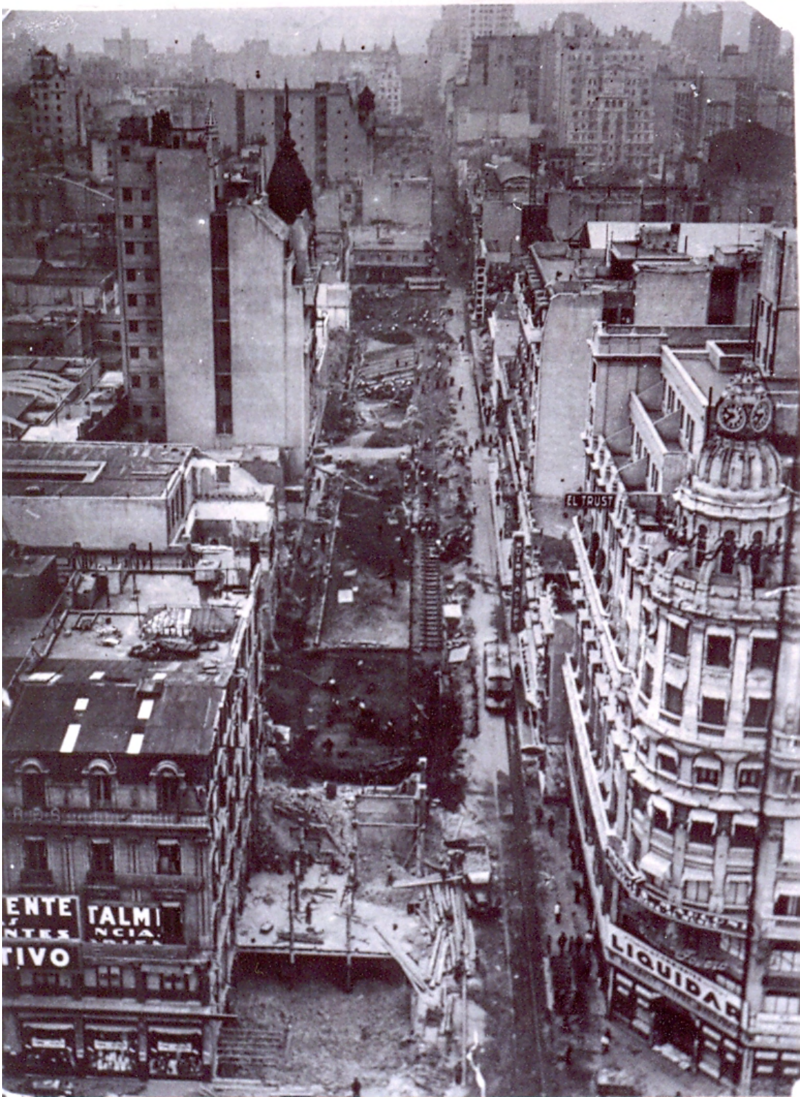
Figura 11 – Obras de alargamento da Avenida Corrientes (e construção da linha B do metrô), cujo leito passou a ocupar o lugar onde existiu o Empire Theatre, Buenos Aires, 1935. Fonte: AGN.
