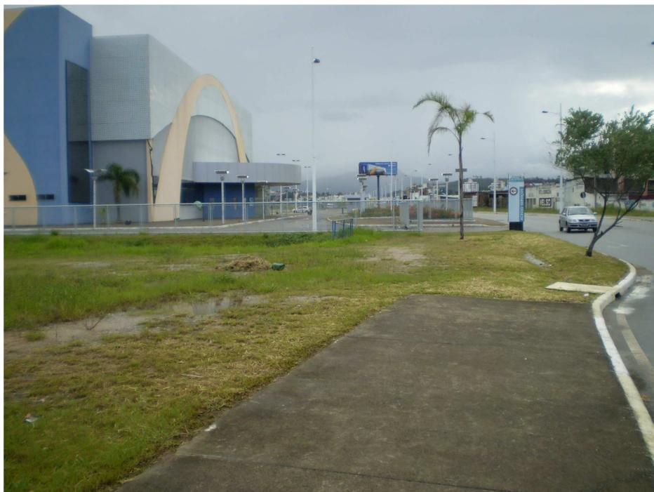
Figura 52 – Descontinuidade dos passeios para pedestres.
