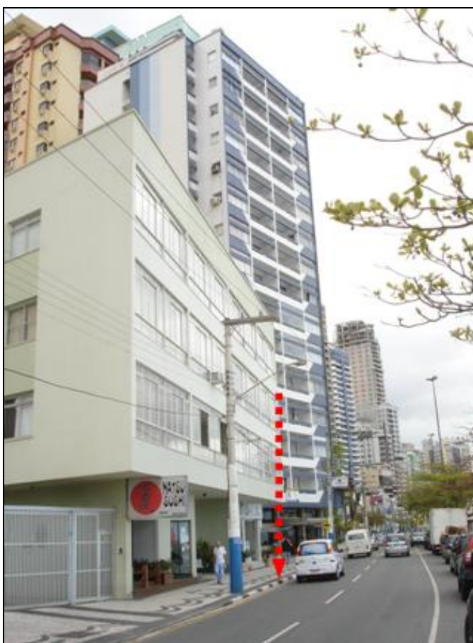
FIGURA 31 – Exemplo de edifício com afastamento frontal, inexistente na Avenida Atlântica (Punta del Este, nº 1.200).
