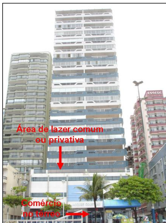
FIGURA 38 – Tipologia dominante na Avenida Atlântica, no final da década de 1980/ início de 1990, com área de lazer não localizada no térreo (Edifício Jacques Costeau, nº 3.200).
