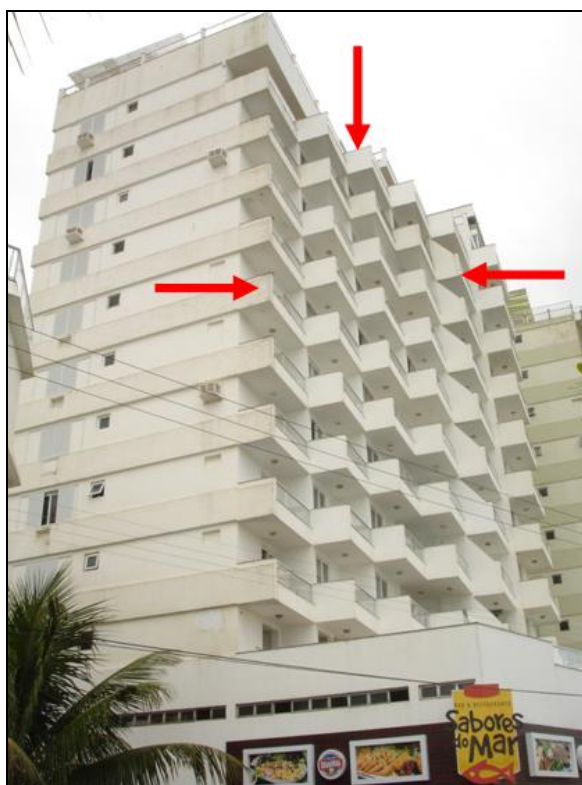
FIGURA 55 – Exemplo de sacada “anexada” ao corpo do edifício (Edifício Ipanema, esquina com Rua 2.000).
