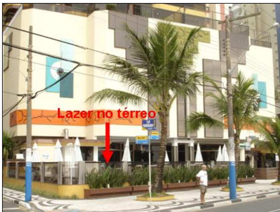
FIGURA 42 – Tipologia dominante na Avenida Atlântica, a partir da década de 1990, com área de lazer no térreo (Edifício Beach Tower, nº 1.000).
