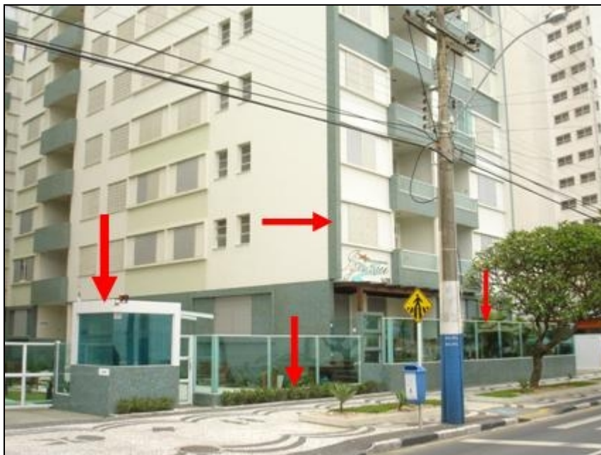
FIGURA 26 – Obra de reforma no Edifício Iguaçu (Avenida Atlântica, nº 1.620), adequando o patrimônio construído aos atuais padrões estético-funcionais. Fonte: Marcelo Danielski (dezembro de 2008)
