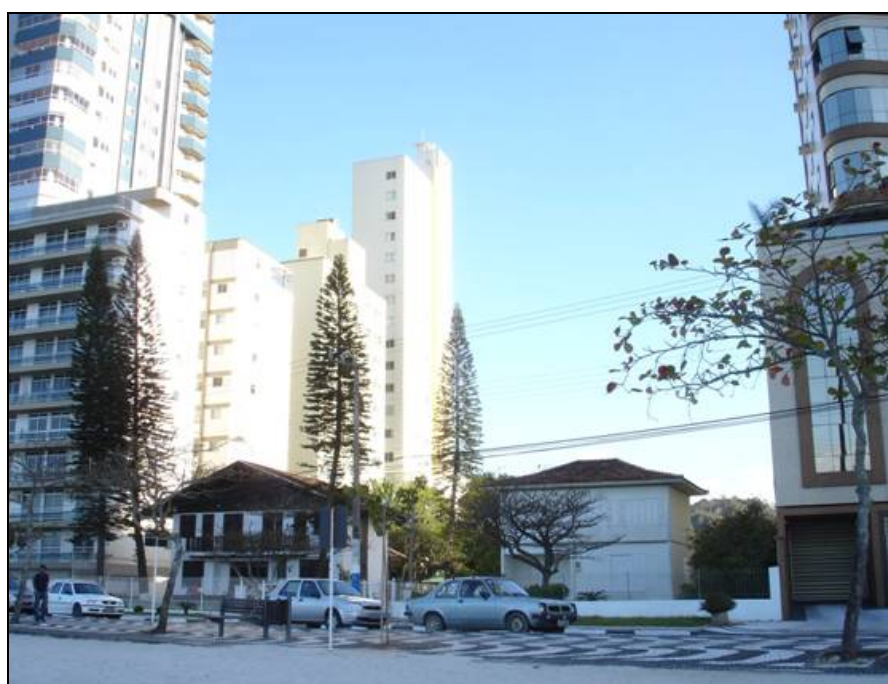
FIGURA 51 – Exemplos de residências unifamiliares na Barra Sul (Avenida Atlântica, nº 4.350 e 4.370), principais “alvos” para o processo de renovação. Fonte: Marcelo Danielski (dezembro de 2008)
