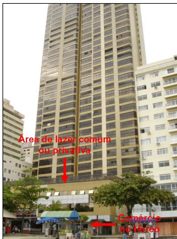
FIGURA 36 – Tipologia dominante na Avenida Atlântica, no final da década de 1980/ início de 1990, com área de lazer não localizada no térreo (Edifício Cosmos, n.º 2.130).
