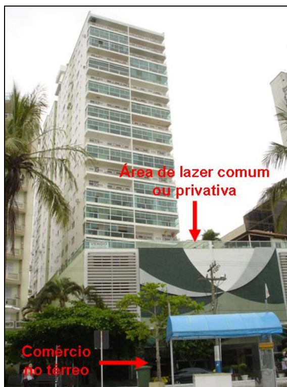
FIGURA 37 – Tipologia dominante na Avenida Atlântica, no final da década de 1980/ início de 1990, com área de lazer não localizada no térreo (Edifício Aldebaran, n.º 2.554).
