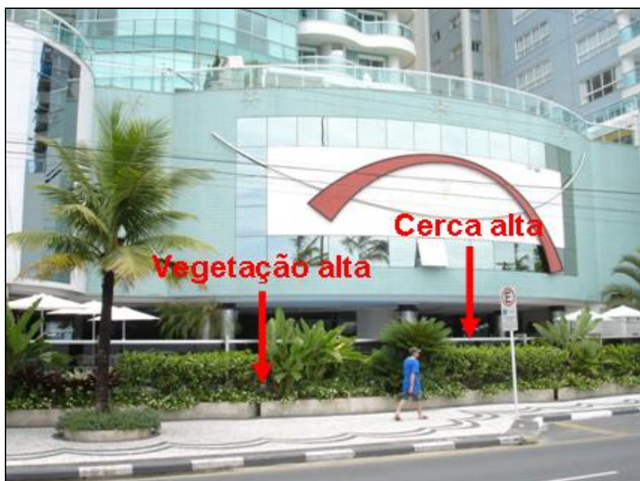
FIGURA 62 – Exemplo de edifício (Saint Antoine, nº 3.330, entregue em 2005) com “centralidade endógena” (barreira visual e espacial no limite entre o espaço público e o privado).
