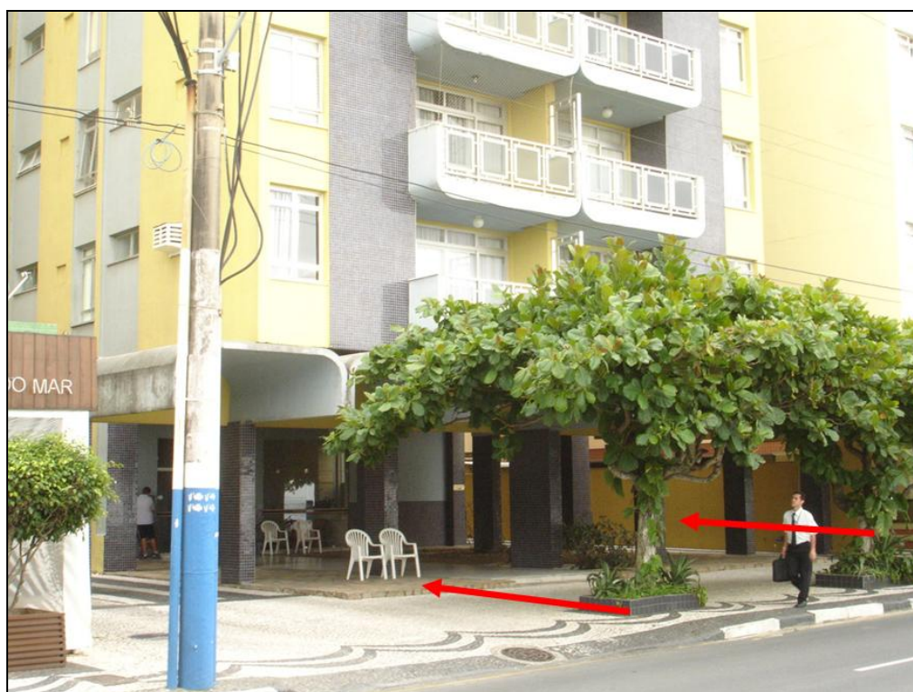
FIGURA 61 – Exemplo de área ociosa no térreo (Edifício Itaipu, nº 720, da década de 1970).
