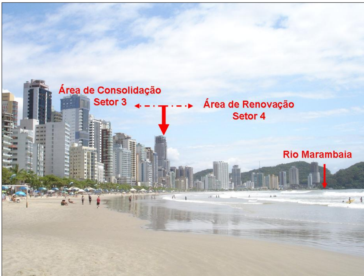
FIGURA 47 – Vista da Área de Renovação (Setor 4/ Pioneiros), com menor adensamento de área construída se comparado com o Setor 3.
