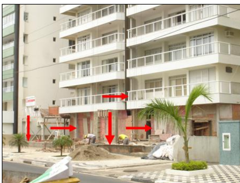
FIGURA 25 – Obra de reforma no Edifício Atobá (Avenida Atlântica, nº 450), adequando o patrimônio construído aos atuais padrões estético-funcionais.
