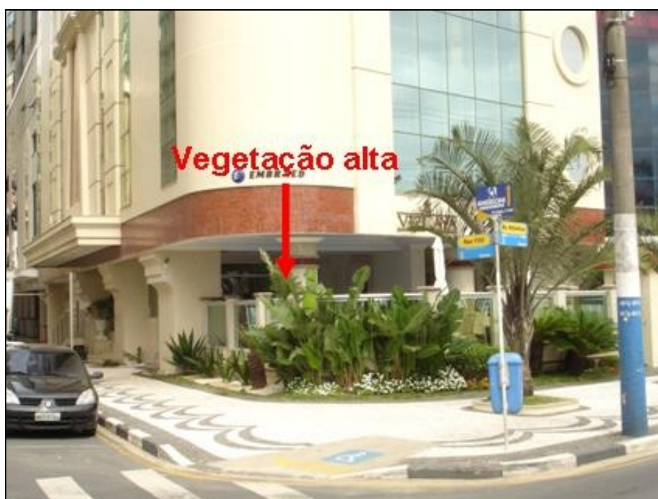
FIGURA 64 – Exemplo de edifício (Viscaya, nº 1.360, entregue em 2006) com “centralidade endógena” (barreira visual e espacial no limite entre o espaço público e o privado).
