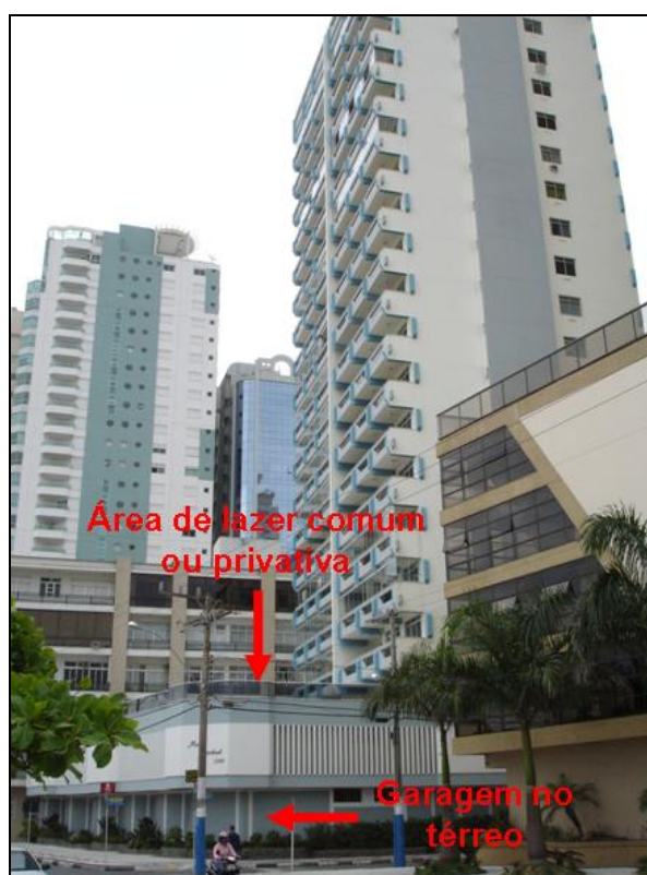
FIGURA 35 – Tipologia dominante na Avenida Atlântica, no final da década de 1980/ início de 1990, com área de lazer não localizada no térreo (Edifício Monte Paschoal, nº 1.300).
