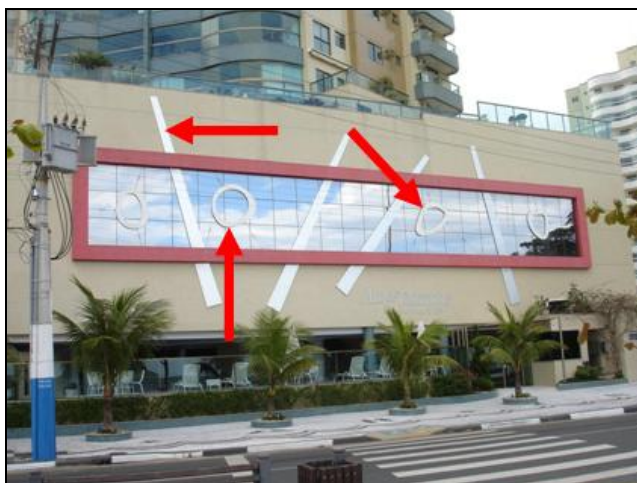
FIGURA 76 – Obra do artista Guido Heuer na Avenida Atlântica (Edifício Arc de Triomphe, nº 222, entregue em 2005).
