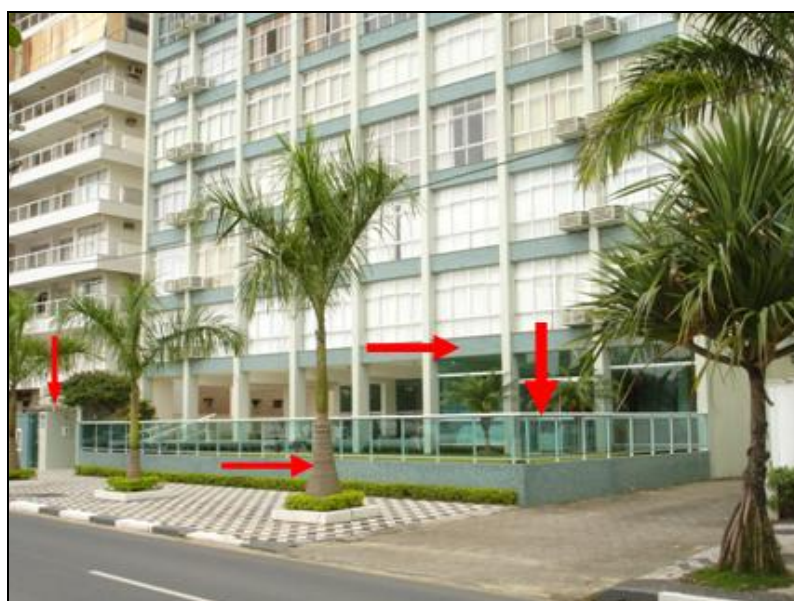
FIGURA 24 – Obra de reforma no Edifício Caravela (Avenida Atlântica, nº 430), adequando o patrimônio construído aos atuais padrões estético-funcionais.
