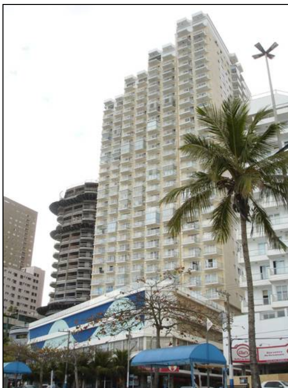
FIGURA 54 – Edifício Imperatriz, construído pela empresa H. Schultz & Cia. (Blumenau).
