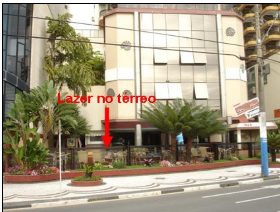
FIGURA 40 – Tipologia dominante na Avenida Atlântica, a partir da década de 1990, com área de lazer no térreo (Edifício Viña del Mar, nº 1.020).
