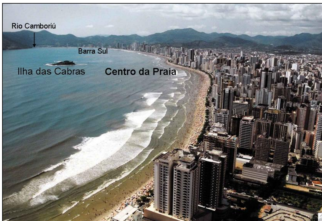
FIGURA 21 – Vista da Praia Central, a partir do Norte, na década de 2000, com intenso adensamento de área construída nas proximidades do Centro da Praia.
