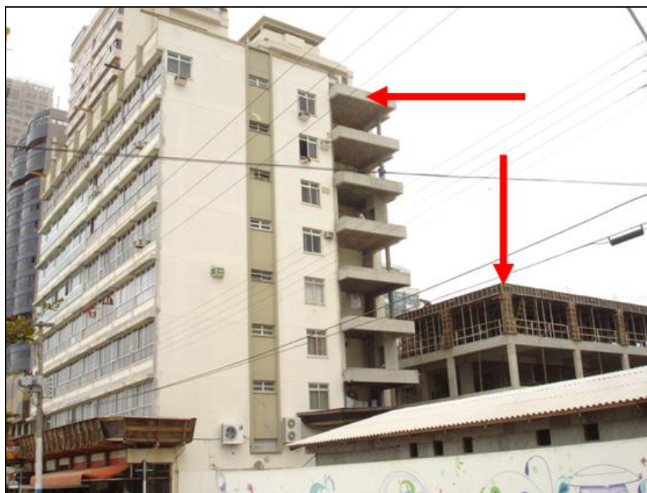
FIGURA 59 – Exemplo de ampliação de área construída, com a execução de um bloco nos fundos do lote (Edifício Saveiro, nº 550).
