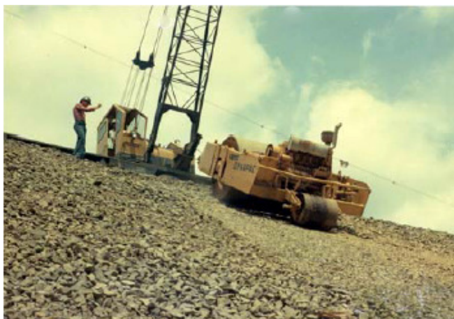
Figura 2.4 - Compactação em talude com rolo compactador tracionado (UHE Foz do Areia) - Método “iô-iô” - Fernandes (2007)
