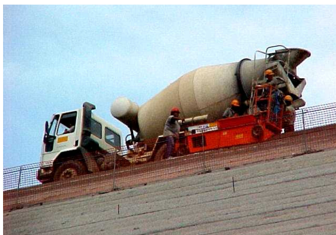
Figura 2.5 - Execução da mureta de concreto extrudado - Método Itá (UHE Machadinho)
