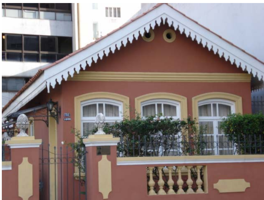
Foto 22 - Casa na av. Bocaiúva esq. Othon Gama D'Eça, Centro, Florianópolis
