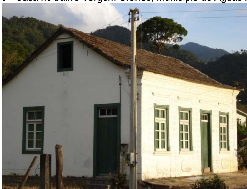
Foto 19 - Casa no bairro Vargem Grande, município de Águas Mornas
