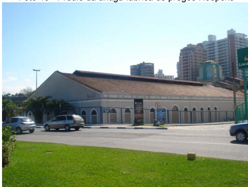
Foto 46 - Prédio da antiga fábrica de pregos Hoepcke
