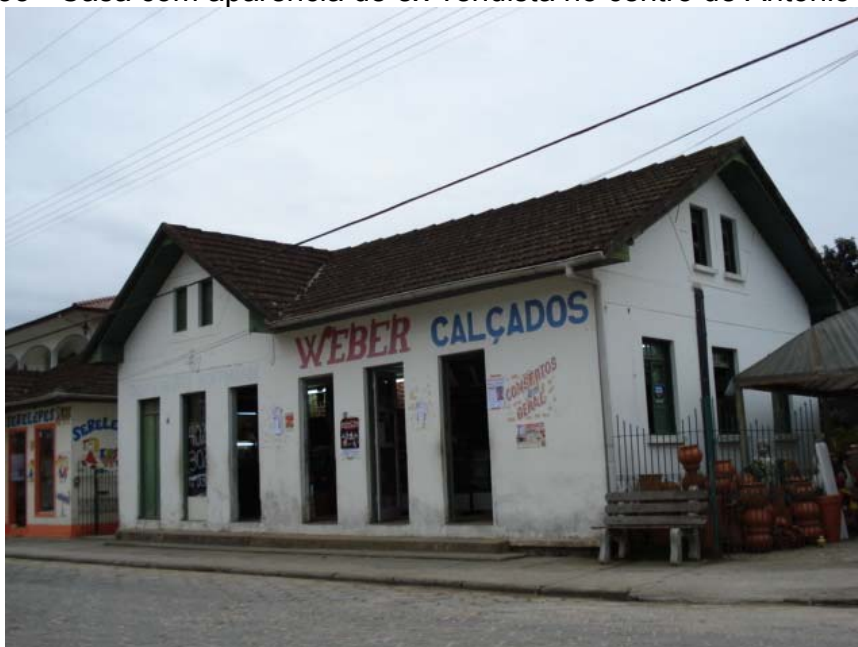
Foto 33 - Casa com aparência de ex-vendista no centro de Antônio Carlos
