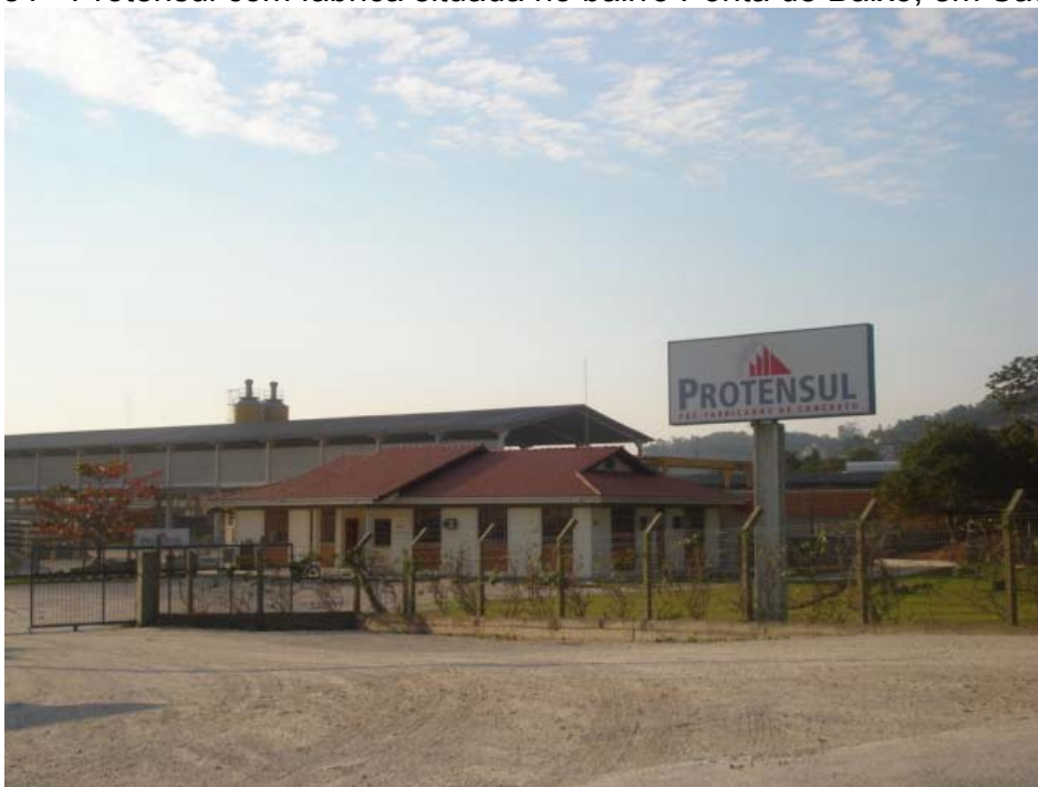
Foto 51 - Protensul com fábrica situada no bairro Ponta de Baixo, em São José
