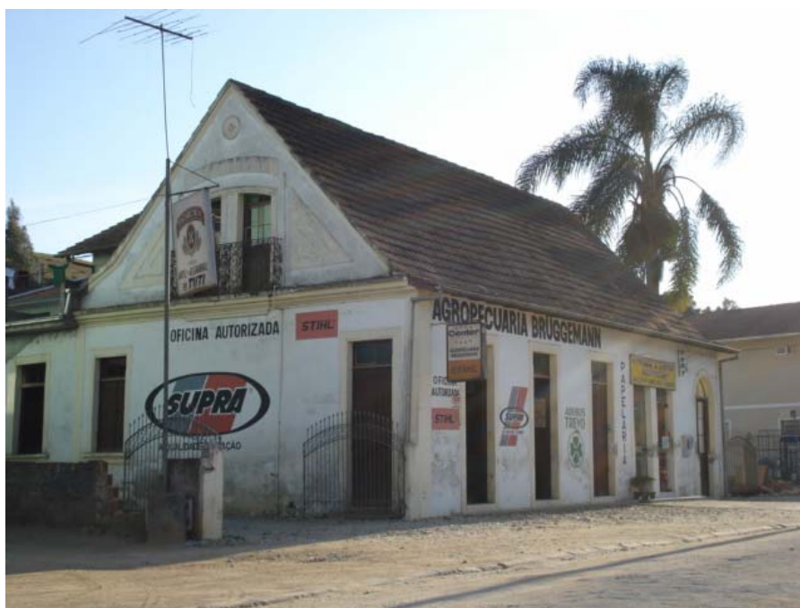
Foto 30 - Antigo prédio de vendeiro, Centro, Rancho Queimado
