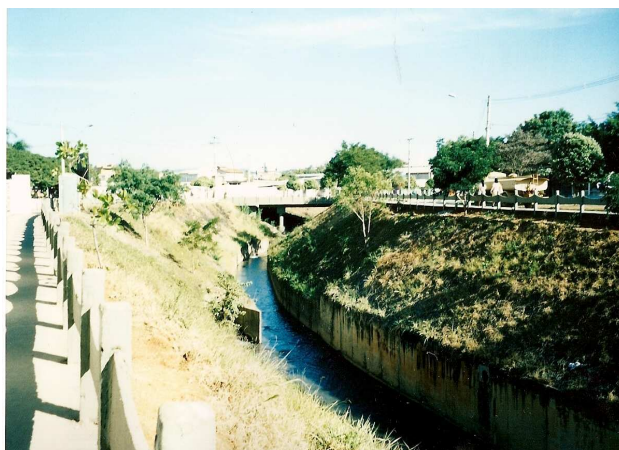
Figura 20 (a), (b) e (c) – Alguns trechos das Avenidas Sanitárias, na figura (a) o curso d'água foi enterrado, em (b) e (c) encontra-se canalizado. Fonte: arquivo pessoal da autora.
