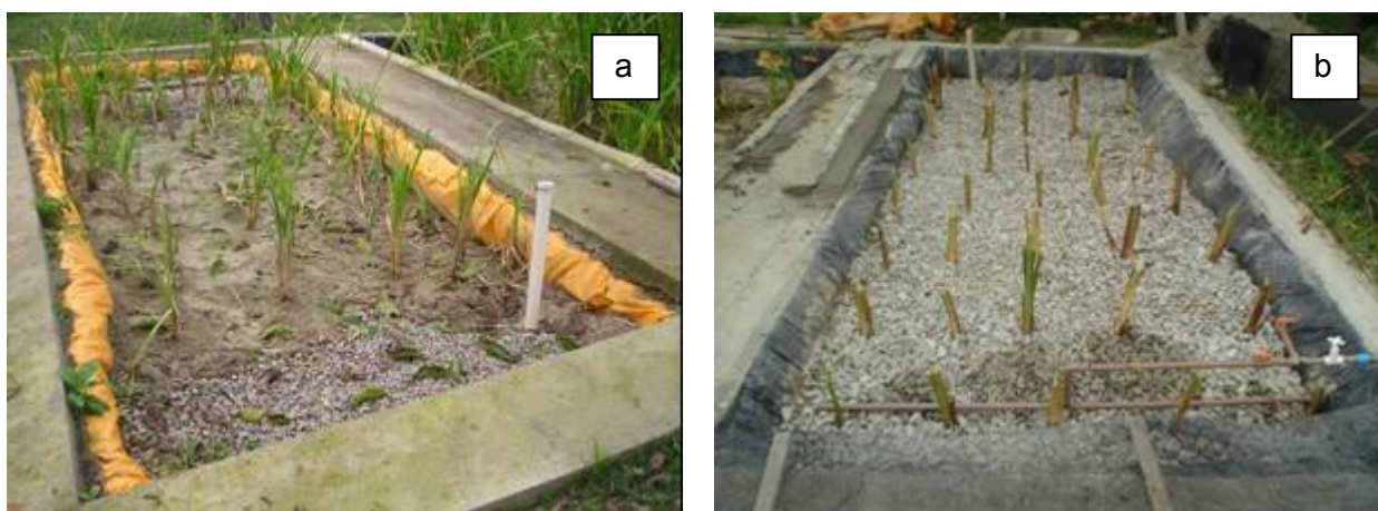
Figura 17: a) Filtro plantado de fluxo horizontal com areia no leito filtrante (H 2 ); b) Filtro plantado de fluxo horizontal com brita no leito filtrante (H 1 ).
