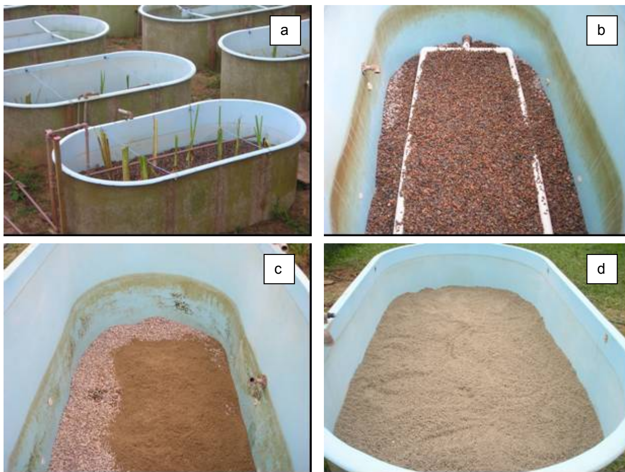
Figura 10: a) Tanques de fibra de vidro; b) Tubulação de coleta apoiada na camada de brita; c) Cobertura de areia; d) Camada de areia.
