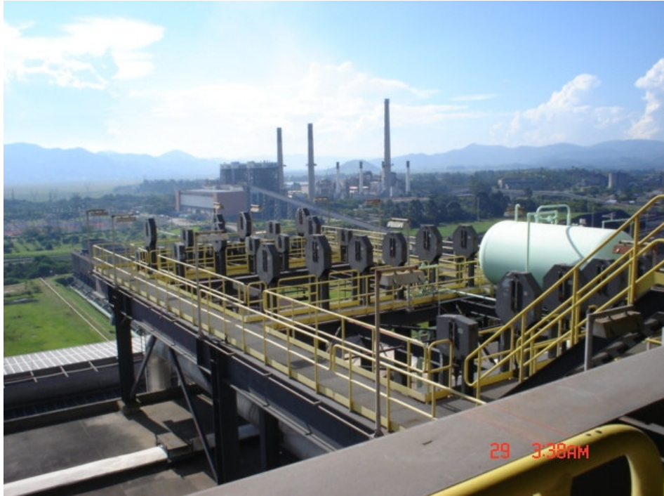
Complexo da Usina Termoelétrica Jorge Lacerda 181
