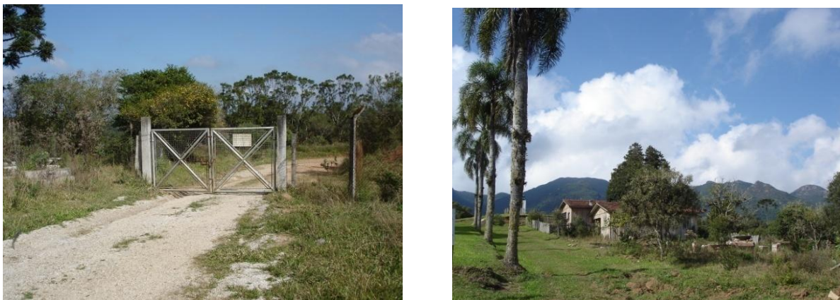
FIGURA 5 - ENTRADA DOS MANANCIAIS DA SERRA, COM DESTAQUE PARA O PORTÃO DE ACESSO À ÁREA RESTRITA E AS ANTIGAS CASAS DOS ZELADORES
