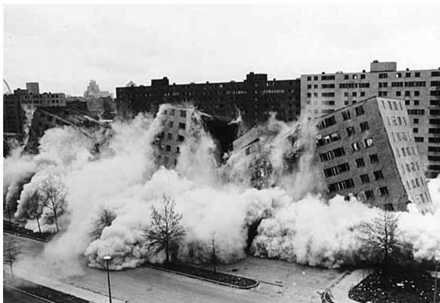
Figura 13. Demolição do conjunto habitacional Pruitt-Igoe, em 1972. Fonte: http://www.vitruvius.com.br/minhacidade/mc176/mc176_02.jpg
