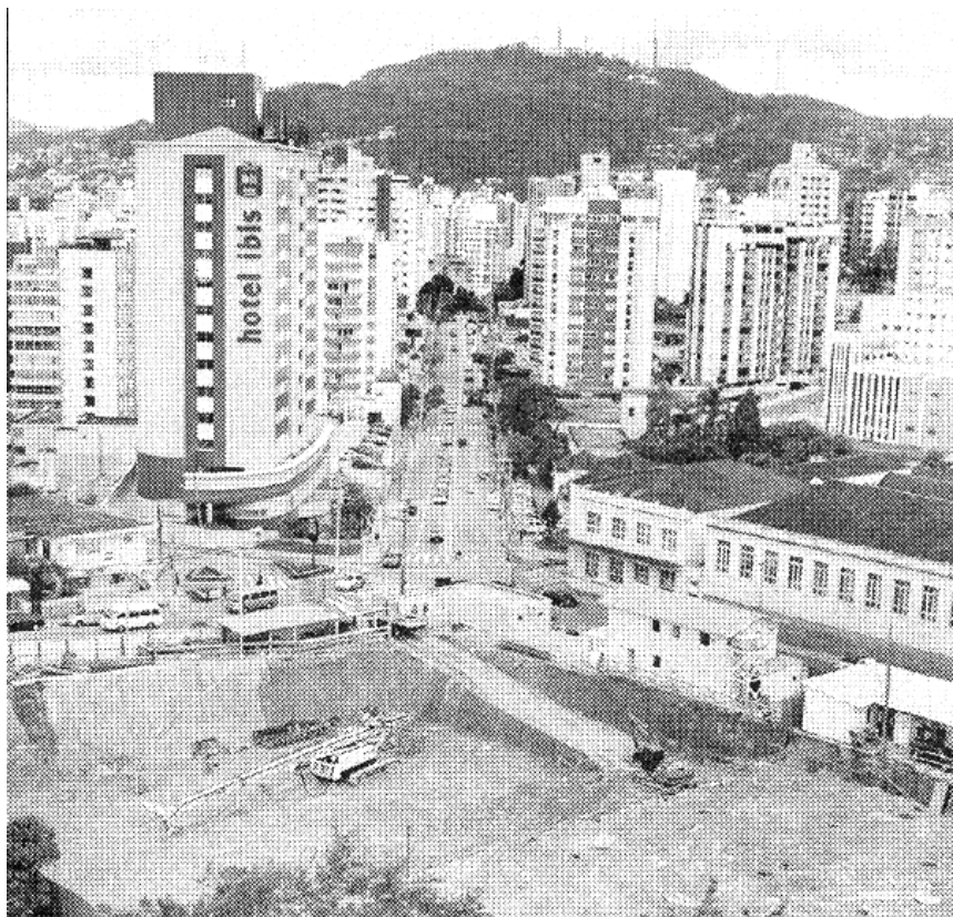
Figura 62. Obra do edifício embargada pelo IPHAN, em dezembro de 2004, no início da construção. Fonte: A Notícia 17/12/2004
