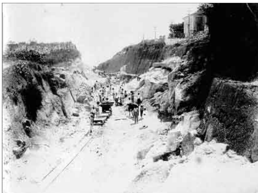
Figura 35. Escavações no morro para implantação da ponte Hercílio Luz. Acima, vista parcial do cemitério municipal. Cerca de 1925. Acervo: Paulo Ricardo Caminha. Fonte: SILVA, 2002.
