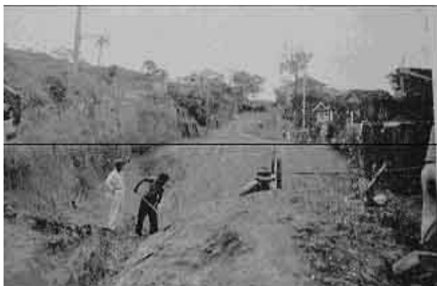
Escavação no alto da rua Felipe Schmidt – 1940 Fonte: AMORA, 2006.
