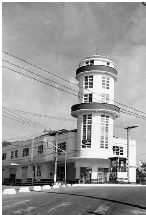
Figura 61. Prédio da empresa Santa Fé Veículos, localizado ao lado da área do Parque da Luz na esquina da rua Felipe Schmidt com a rua Hoepcke. Demolido. Fonte: UFSC
