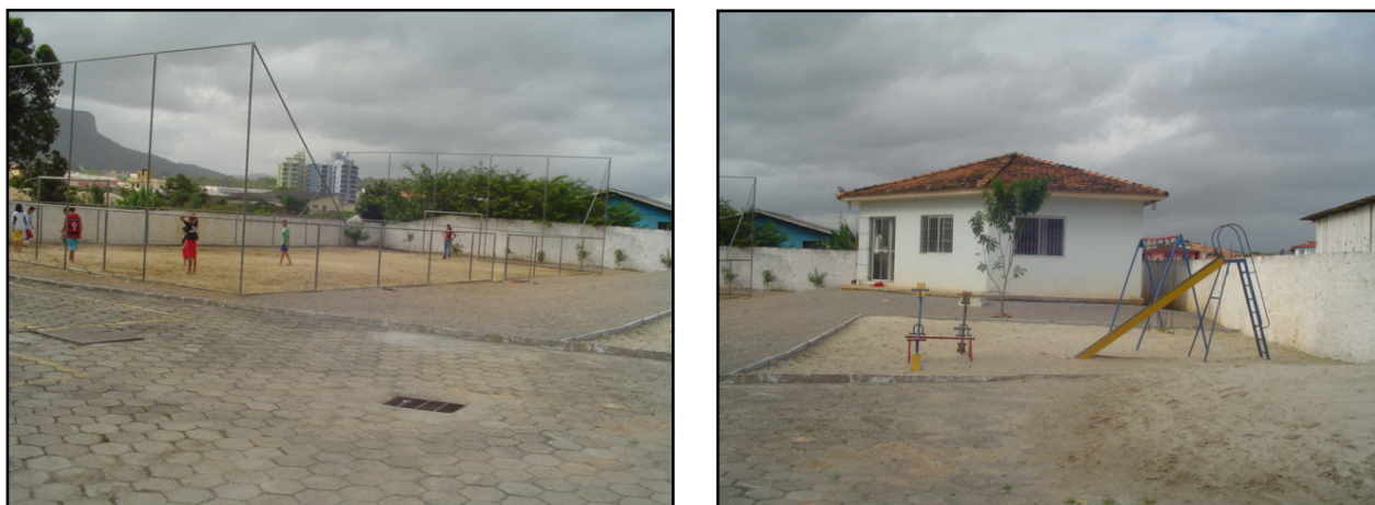
FIGURA 77 – Equipamentos comunitários – quadra de areia, salão de festa e play-ground.
