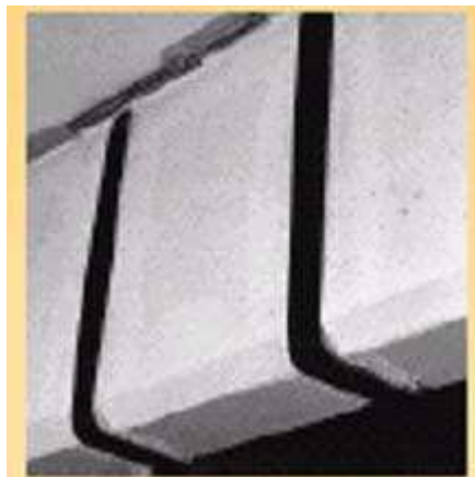
Figura 3.15 – Laminados pré-fabricados em forma de L (Sika® CarboShear L, 2003).
