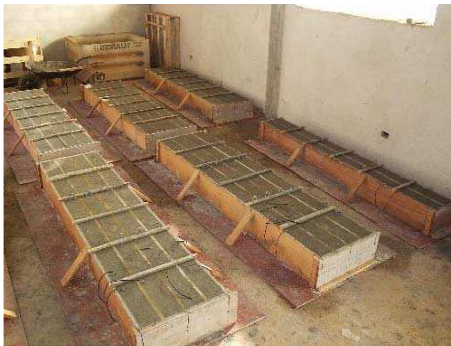
Figura 5.10- Vigas nas formas
