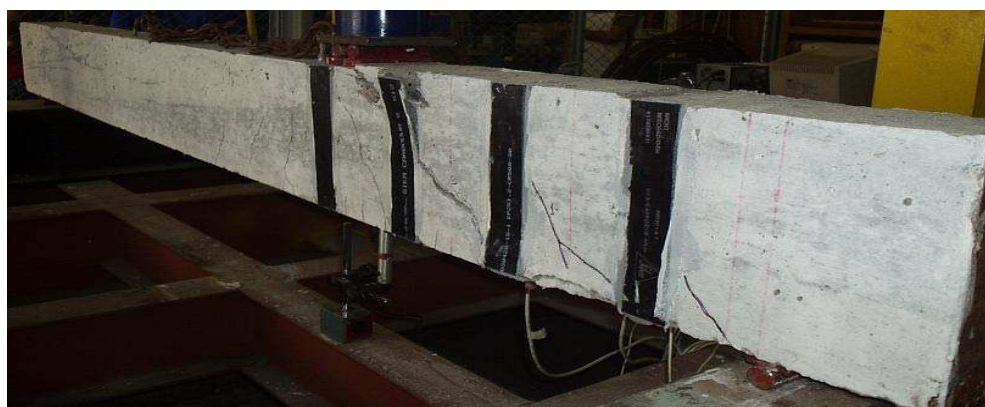
Figura 6.10 – Viga 16 após o ensaio.
