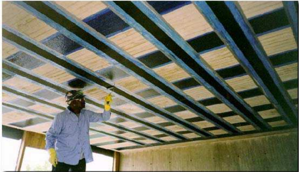
Figura 2.7 - Reforço em lajes (MASTER BUILDERS, 2001).
