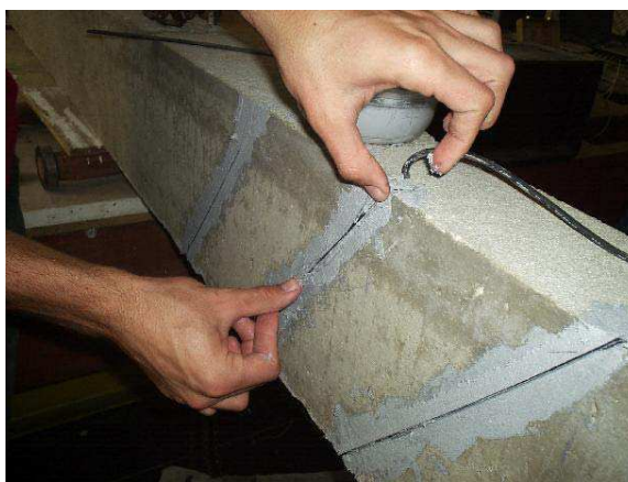
Figura 5.19 – Aplicação do adesivo e inserção dos laminados
