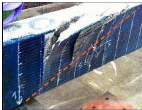
Figura 3.41 – Descolamento do reforço com destacamento do cobrimento em uma porção triangular sobre a fissura diagonal principal no vão de cisalhamento (PELLEGRINO E MODENA, 2006).
