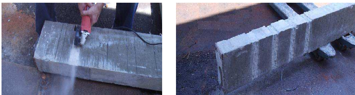
Figura 5.14 – Abertura de faixas no concreto de recobrimento
