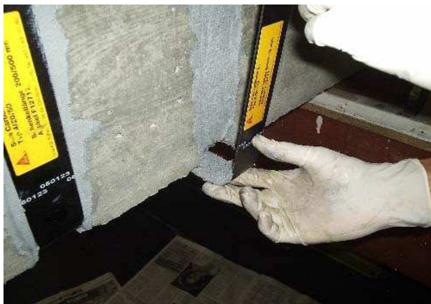
Figura 5.16 – Colagem dos laminados
