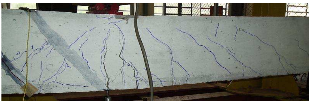
Figura 6.7- Viga 8 após o ensaio
