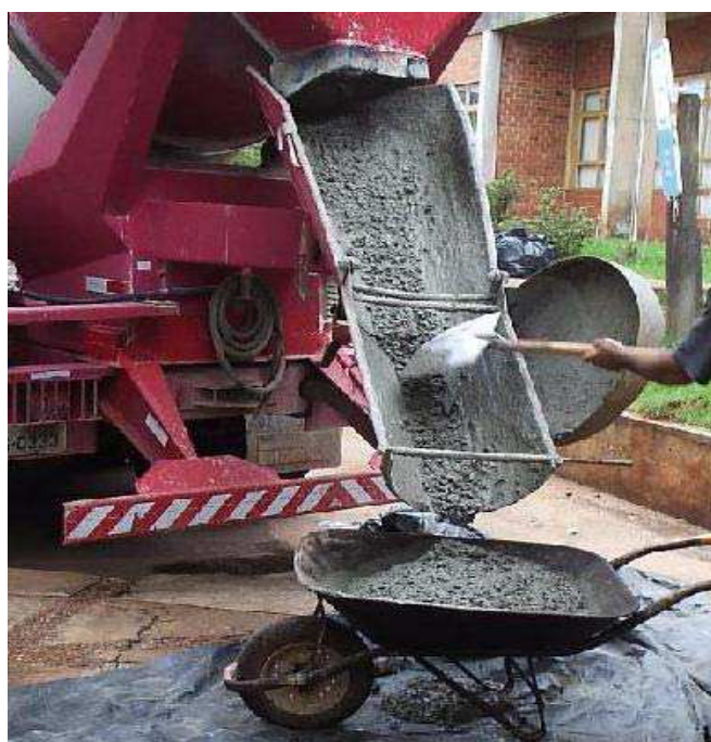
Figura 5.6 – Concreto usinado
