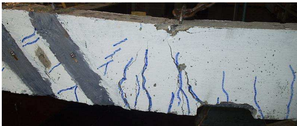
Figura 6.18 – Viga 34 após o ensaio .
