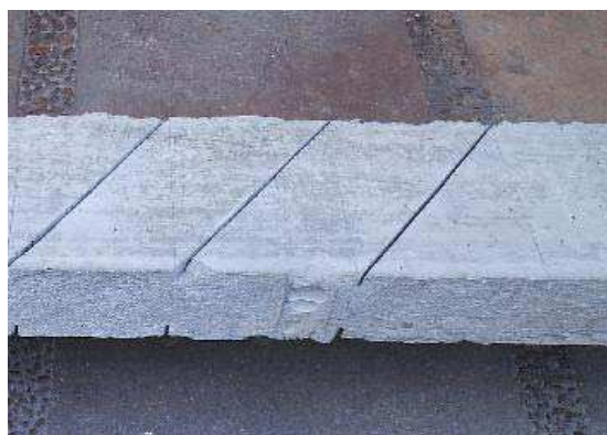
Figura 5.17 – Abertura de ranhuras no concreto de recobrimento
