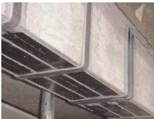
Figura 2.16 – Reforço à flexão e ao cisalhamento
