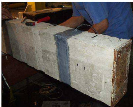
Figura 5.22 - Preparo do reforço da viga curada in situ ”
