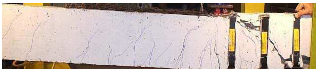
Figura 6.14 – Viga 32 após o ensaio
