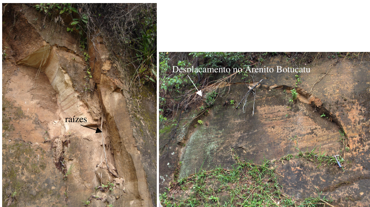
Figura 50 e 51: Diáclases de descompressão no paredão do Arenito Botucatu, nas margens da rodovia BR 277
