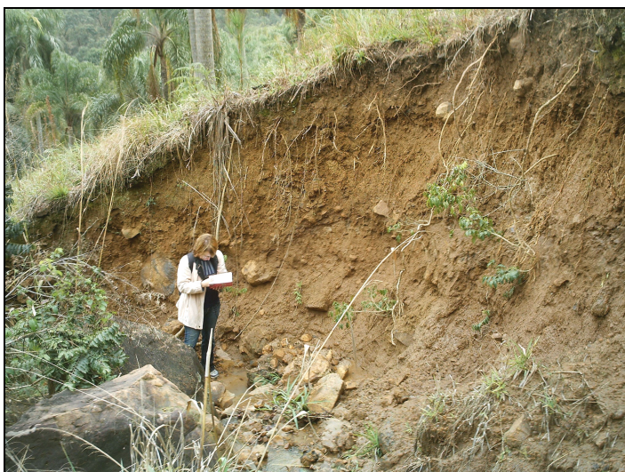
Figura 28: Detalhe do processo de alargamento das margens do canal, decorrente do deslizamento e da erosão das margens. Foto: Andrey Binda (Julho de 2007)
