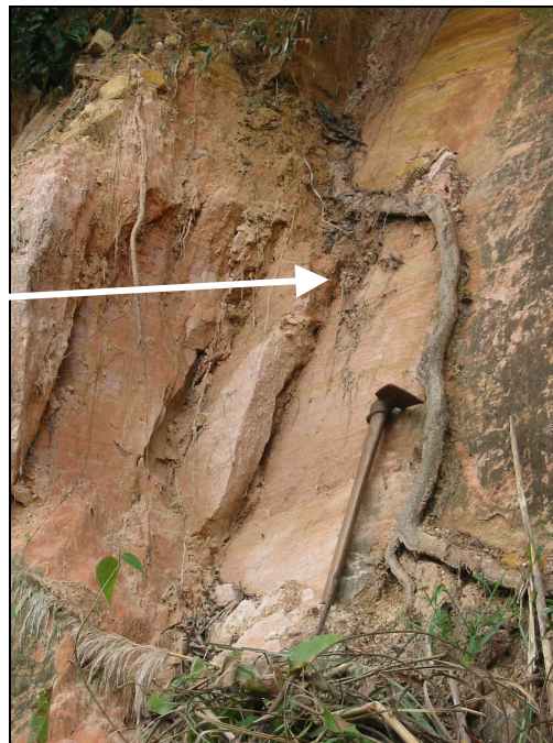
Figura 16 e 17: Queda de bloco no Arenito Botucatu, nas margens da rodovia. Nas figuras é possível observar o papel das raízes da cobertura vegetal agindo no processo. Foto: Solange F. Vieira (março de 2007).
