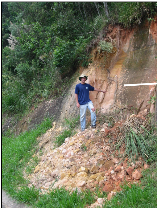
Figura 16 e 17: Queda de bloco no Arenito Botucatu, nas margens da rodovia. Nas figuras é possível observar o papel das raízes da cobertura vegetal agindo no processo. Foto: Solange F. Vieira (março de 2007).
