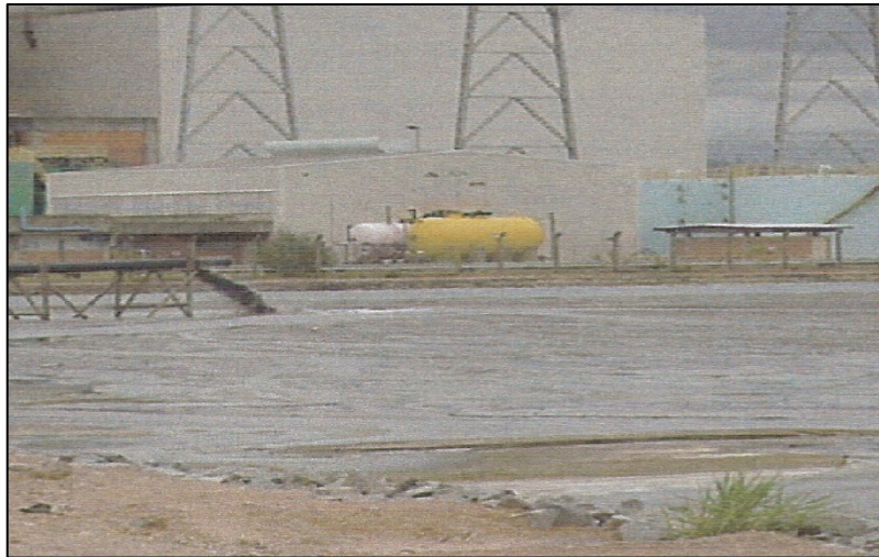
Figura 03 – Depósito de cinza pesada em bacia de sedimentação
