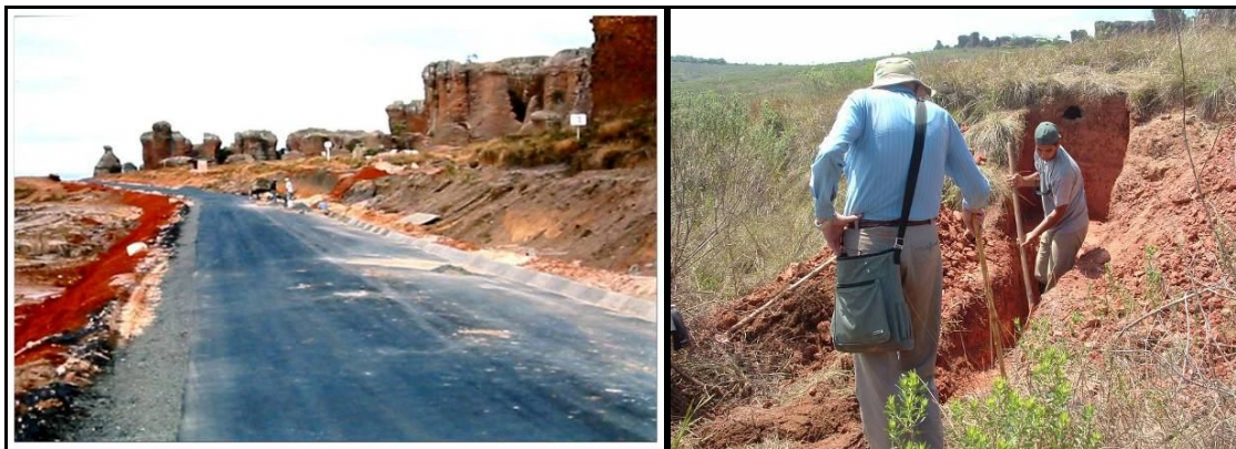
FIGURA 20- Construção da estrada interna; Abertura de trincheiras, acompanhadas pelo orientador.
