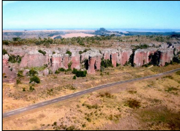
FIGURA 23- Arqueamento da superfície sugere a compactação das camadas argilosas do varvito e embaciamento do Arenito.
