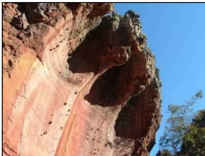
FIGURA 24- Aspecto do escoamento superficial nas paredes do Arenito Vila Velha
