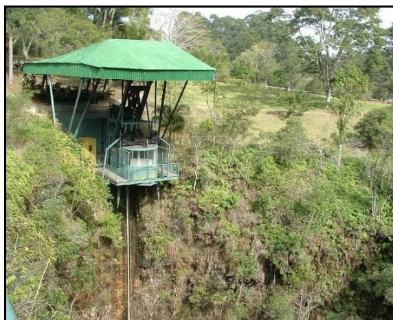
FIGURA 56- Furna Um e o elevador
