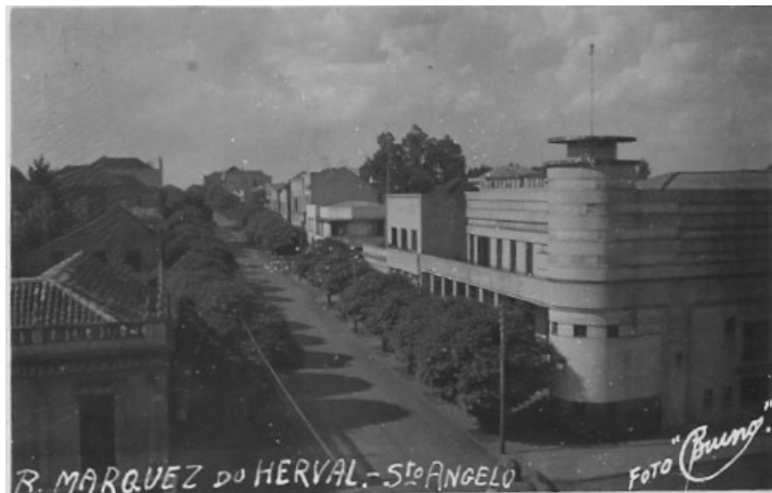
Figura 78 – Entroncamento das Ruas Marquês do Herval com a 14 de Julho. Vista Norte
