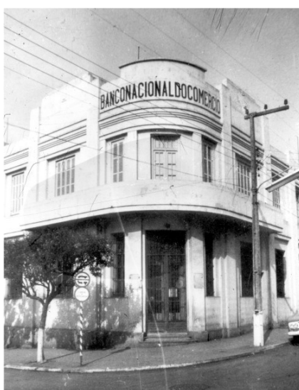
Figura 42 – Banco Nacional do Comércio. Possivelmente Construtora Azevedo, Moura e Gertum. FONTE: AHMACPS
