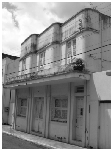
Figura 108 – Antiga edificação de Darwin Pereira Travessa Mauá. 1939 Construtora Santo Angelense Ltda FOTO: Rodrigo Fabrício Kerber, 2007.
