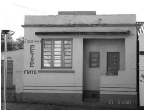
Figura 88 – Antiga residência de Celso Moraes Rua Antunes Ribas. 1934 Construtora Santo Angelense Ltda Recentemente demolida. FOTO: Rodrigo Fabricio Kerber, 2007.
