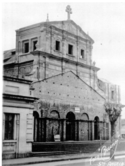
Figura 84 – Fase de execução da nova fachada adaptada à Igreja da Matriz FONTE: AHMACPS
