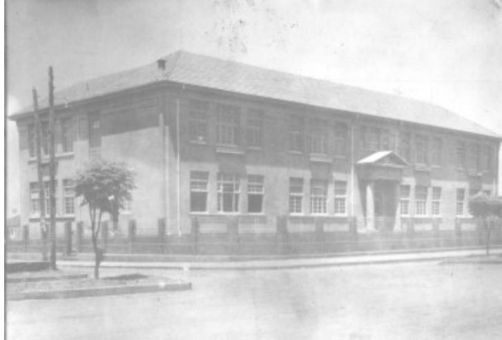
Figura 39 – Colégio Elementar de Santo Ângelo. Secretaria de Obras Públicas do Estado do Rio Grande do Sul, 1934-36. FONTE: AHMACPS
