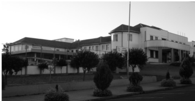
Figura 40 - Associação de Assistência aos tuberculosos Sanatório. Construtora Santo Angelense Ltda FOTO: Rodrigo Fabrício Kerber, 2007.
