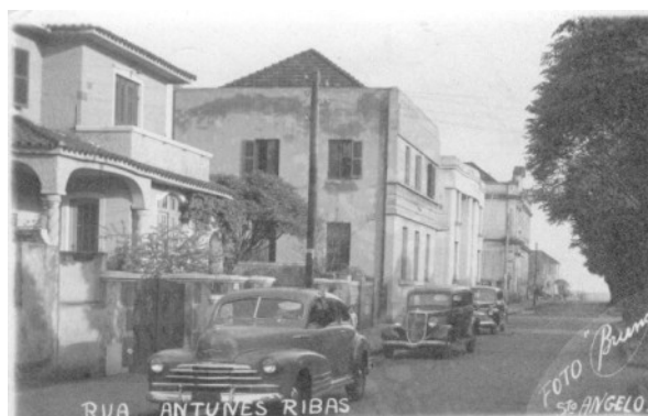
Figura 53 – Rua Antunes Ribas. Vista Sul, proximidades da Prefeitura. Década de 1950.
