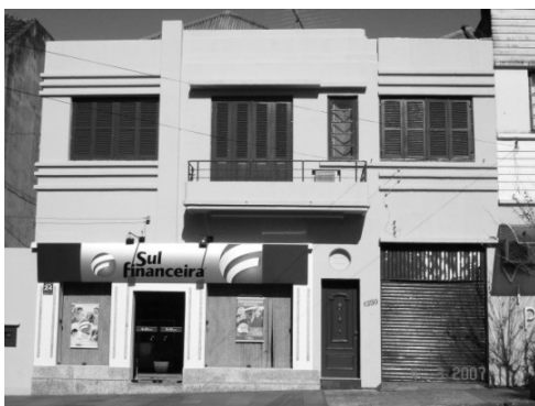
Figura 103 – Antiga edificação de Laurindo Piccoli Rua Marechal Floriano. 1937 Construtora Santo Angelense Ltda FOTO: Rodrigo Fabrício Kerber, 2007.
