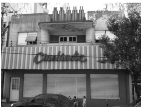
Figura 115 – Antigo Edifício Kehl para Adolfo Kehl Avenida Brasil. 1945 Construtora Santo Angelense Ltda FOTO: Rodrigo Fabrício Kerber, 2004.
