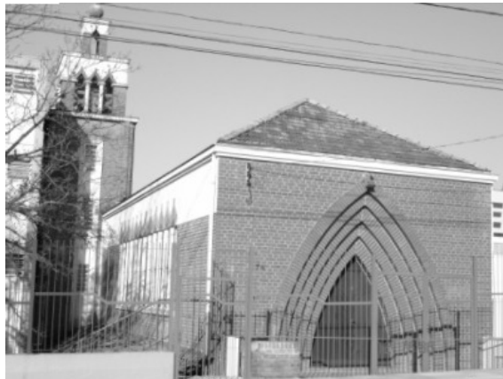
Figura 05 – Igreja Martin Luther. Arquiteto Siegfried Bertholdo Costa, 1934-36
