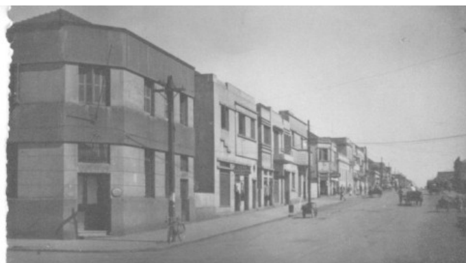
Figura 66 – Rua Marechal Floriano. Vista Norte, década de 1940. Conjunto de edificações feitas pela construtora Santo Angelense Ltda. FONTE: AHMACPS
