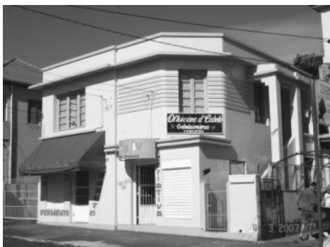
Figura 101 – Antigo Sobrado de João Pippi Rua Marechal Floriano. 1935 Construtora Santo Angelense Ltda FOTO: Rodrigo Fabrício Kerber, 2007.
