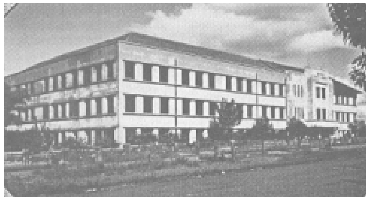
Figura 38 – Grupo Ginásio Municipal de Santo Ângelo. Construtora Santo Angelense Ltda
