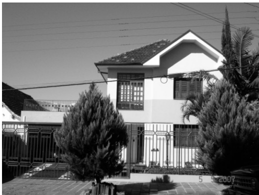
Figura 89 – Antiga residência de Florimundo Fernandes dos Santos Bento Gonçalves. 1934 Construtora Santo Angelense Ltda FOTO: Rodrigo Fabrício Kerber, 2007.
