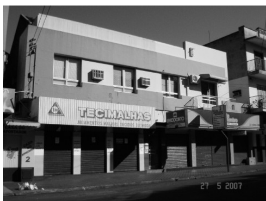
Figura 109 – Antigo sobrado para família Hocchein Rua Marechal Floriano. 1941. Construtora Santo Angelense Ltda FOTO: Rodrigo Fabrício Kerber, 2007.
