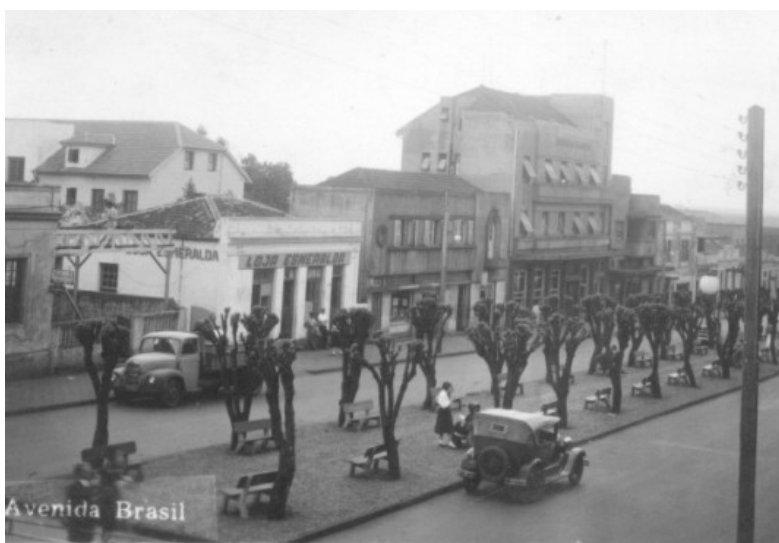
Figura 61 – Avenida Brasil. Vista Nordeste, década de 1940. Destaque para o conjunto de edificações no meio da quadra feitas pela construtora Santo Angelense Ltda, nas décadas de 1930 e 1940. FONTE: Acervo particular Tiago Van Helden
