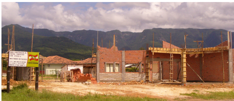
Figura 16 – Construção do Portal Turístico de Praia Grande.
