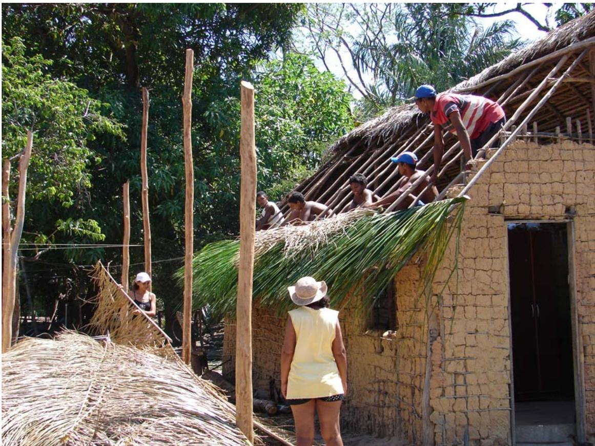
Figura 9: Casa recebendo novo telhado de palha para inverno.
