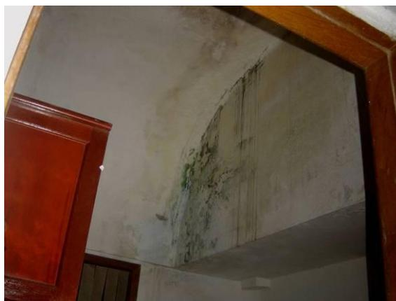
Figura 22: Infiltração na cobertura
