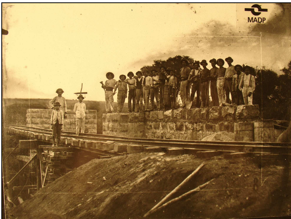
Imagem 4 – Construção da estrada de ferro (Coleção Família Beck, 1911).
