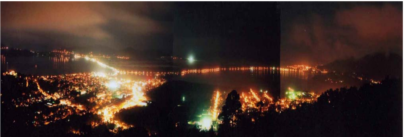
Fig. 8 – Panorama sobre a Estrutura Urbana da área de estudo
