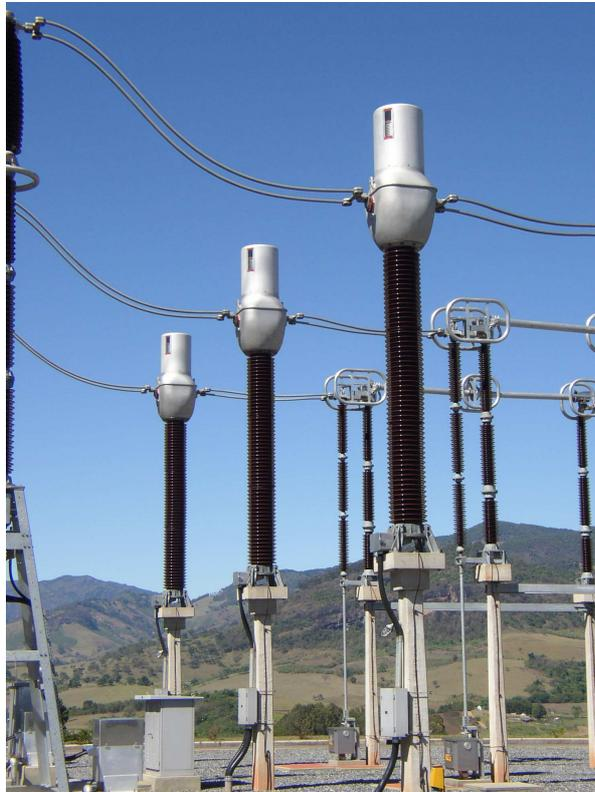
Figura 2.4: Instalação de transformadores de corrente tipo barra fixa de alta tensão (AREVA, 2000)
