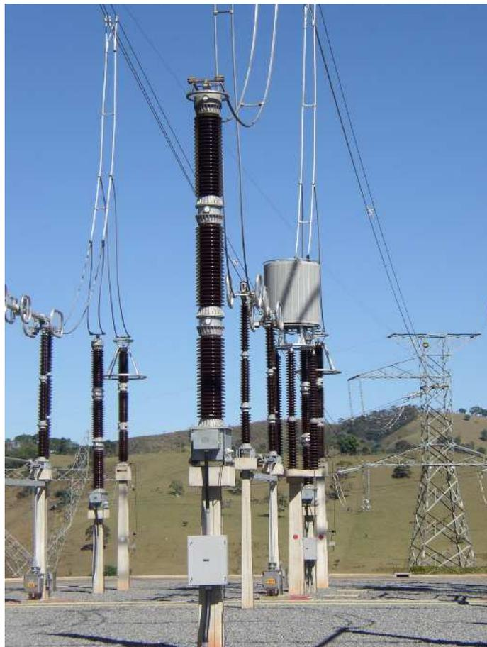
Figura 2.15: Transformador de potencial capacitivo instalado em uma subestação (AREVA, 2000)
