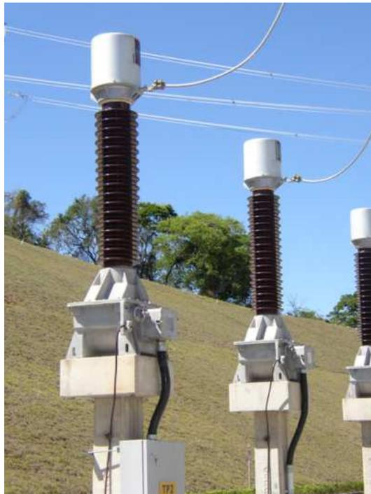
Figura 2.8: Transformadores de potencial indutivo instalados em uma subestação (AREVA, 2000)
