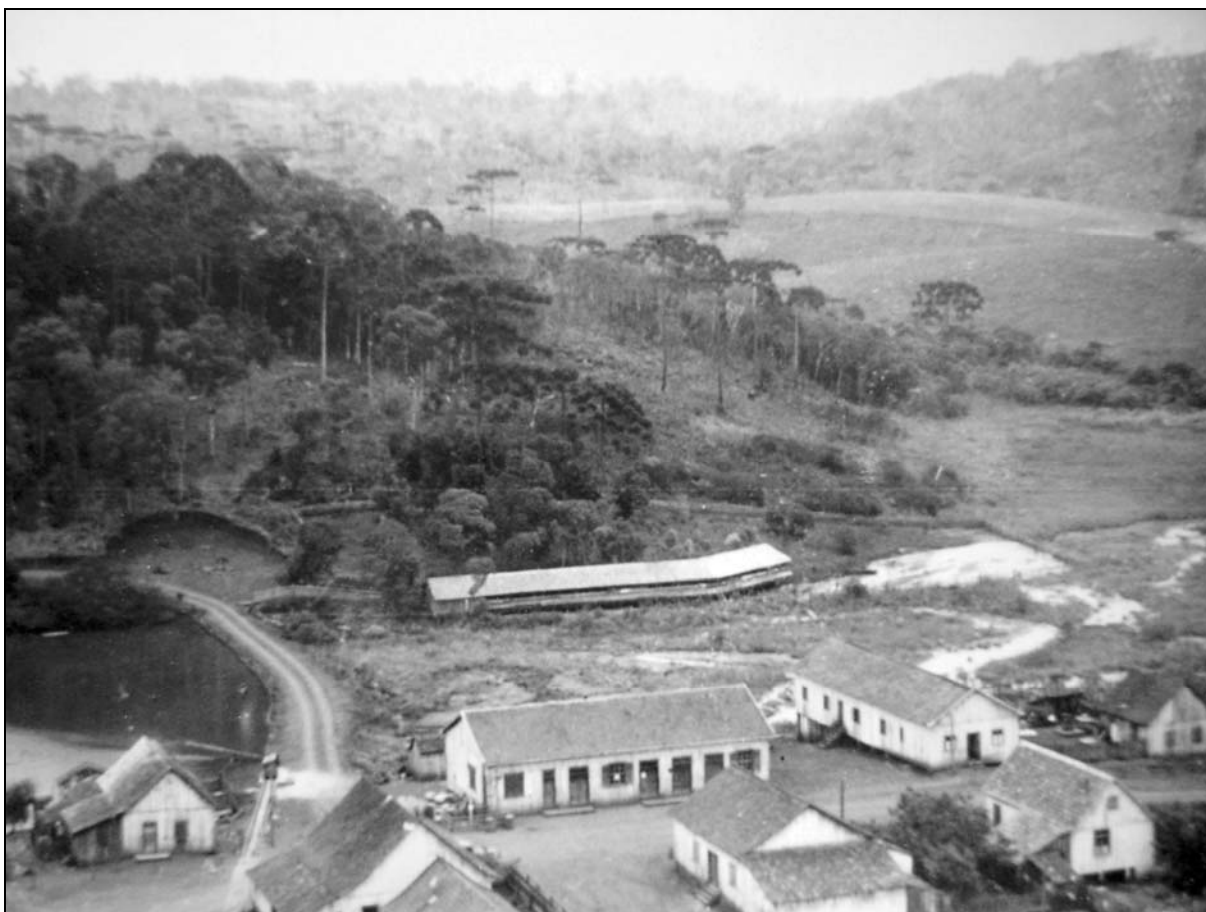
FIGURA 21: Foto da vista parcial de Butiá Verde, década de 1950. Nesta imagem, possivelmente obtida do alto da chaminé construída para a serraria em 1952, observa-se o lago, construído em 1941, a partir do represamento do arroio Passo Novo, além do armazém, localizado à direita, com o chiqueiro mais ao fundo.
