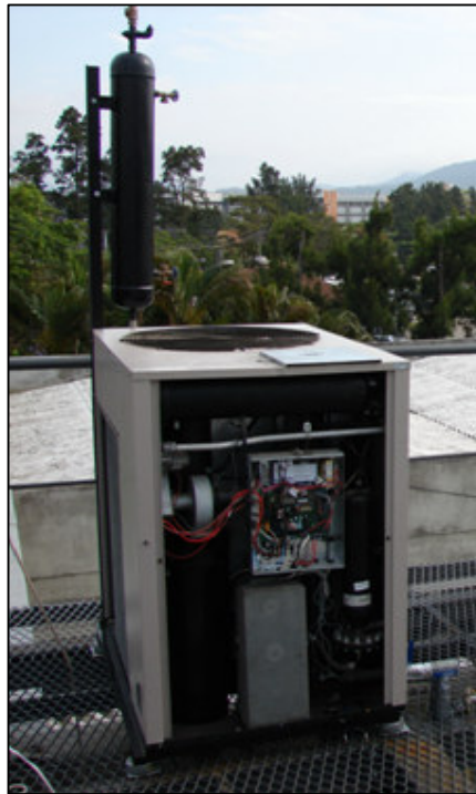
Figura 3.14 - Máquina de refrigeração por absorção Robur ACF 60.
