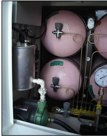
(a) (b) Figura 3.3 - Sistema de anticongelamento da válvula redutora de pressão (a) e cavalete (b).
