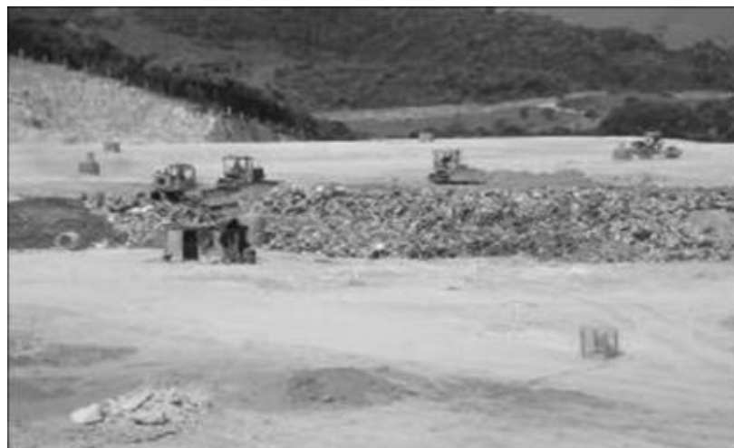
Figura 3.4. Vista parcial da frente de serviço do aterro.
