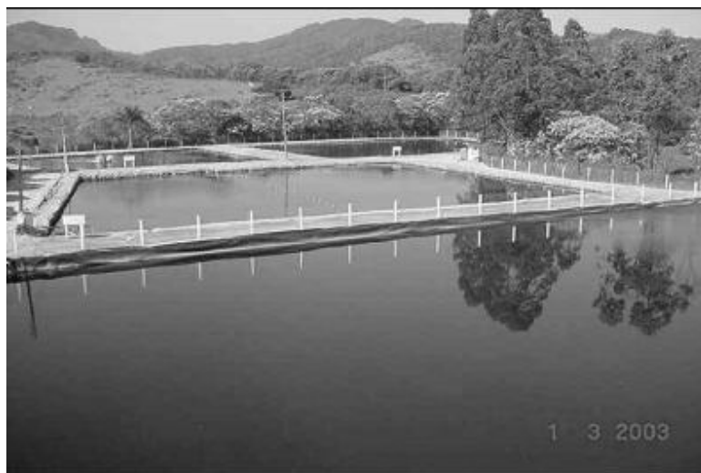
Figura 3.6. Sistema de Lagoas de Estabilização: Aterro Sanitário de Tijuquinhas, Biguaçu – SC. Fonte: BRENTANO (2006)
