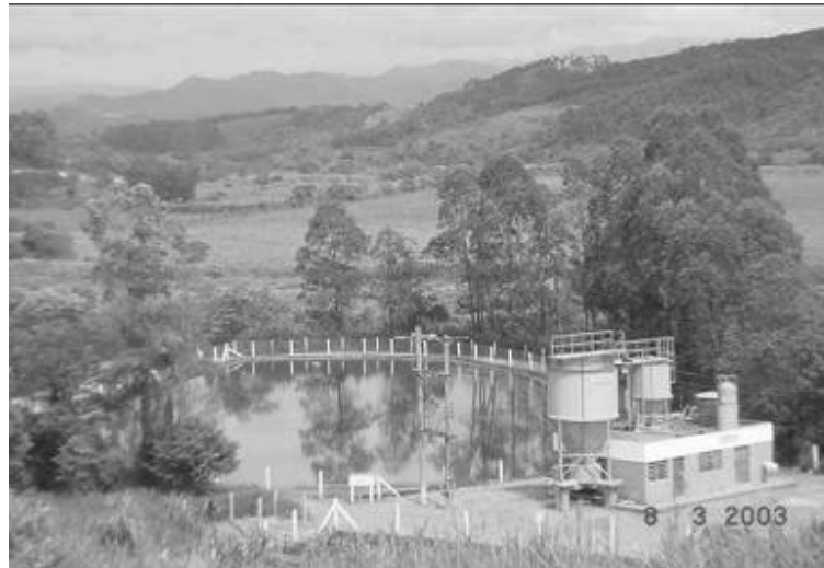
Figura 3.5. Reator UASB e Laboratório de Tratamento Físico-Químico.
