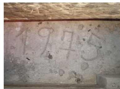
Figura 86- Registro da argamassa do forro de estuque.
