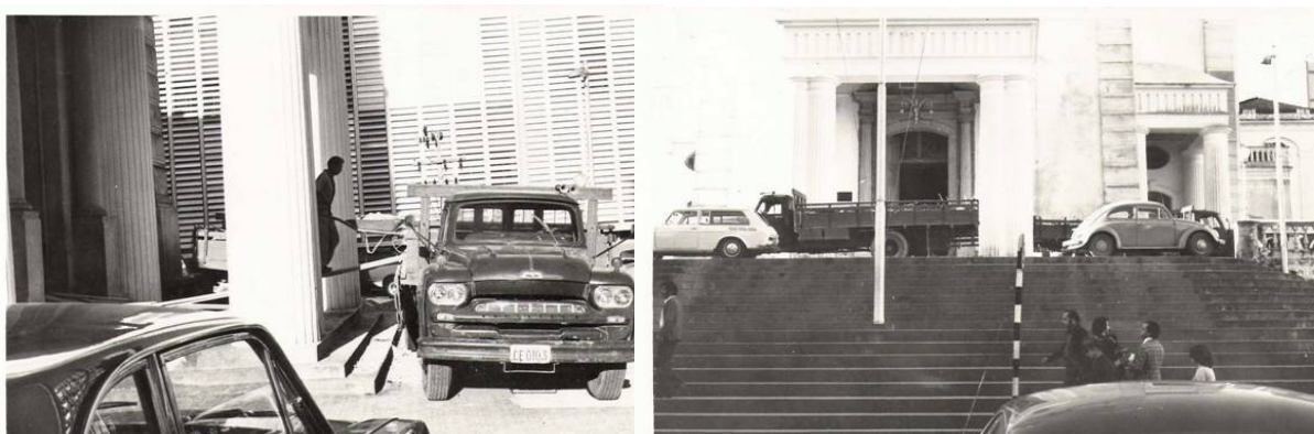
Figura 56 - Imagens do Adro durante as obras de 1974.
