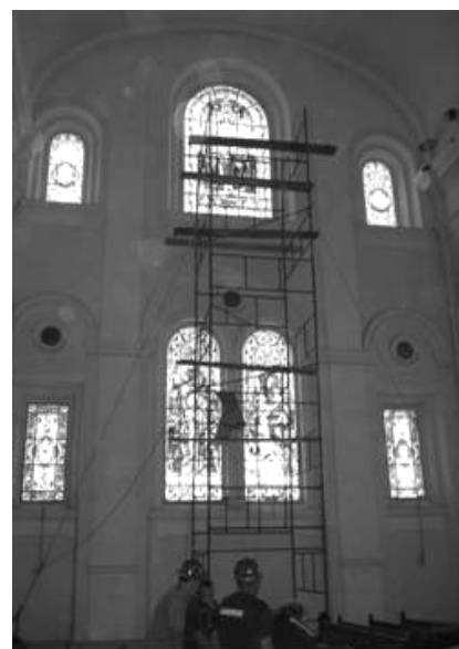
Figura 88 - Imagem da estrutura de andaimes para remoção dos vitrais. Local: lateral direita da Nave Central. Fonte: Acervo da autora, 2006.
