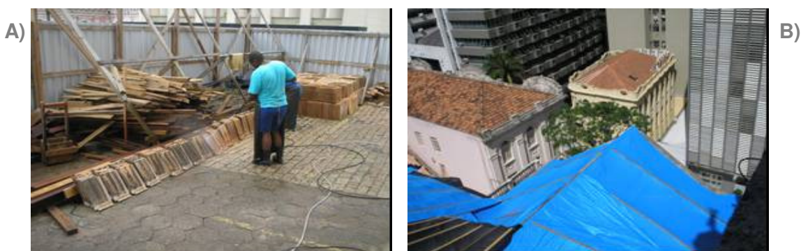
Figura 80 - Imagens das obras na cobertura.
