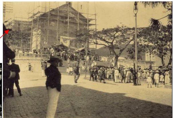
Figura 21 - Reforma externa da Catedral -1922. Andaimes para a substituição do reboco externo. Fonte: Casa da Memória- Acervo Documental
