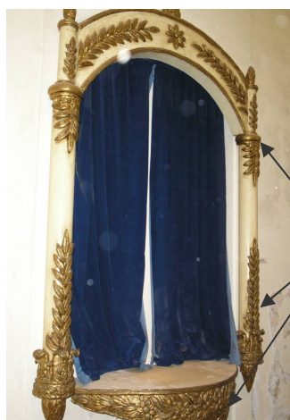
Figura 63 - Nicho de São Judas Tadeu na Capela de N. Sr ª . das Dores. Aplicação com massa epóxi para fazer os ornamentos dourados. Fonte: da autora- 2005
