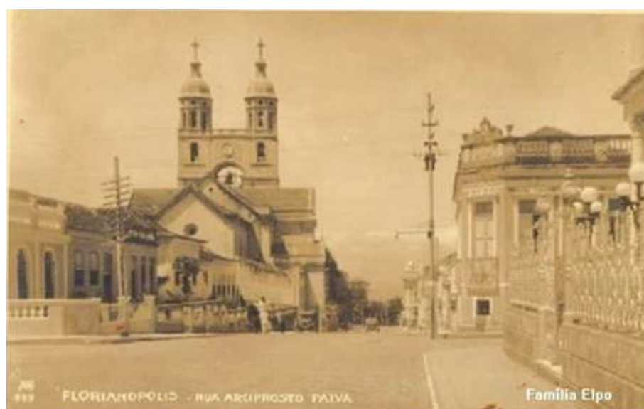
Figura 39 - Rua Arcipreste Paiva após o alinhamento. Este fato causou a diminuição do adro da Matriz e supressão da Capela do Santíssimo Sacramento. Autor foto: Família Elpo Acervo Fabiano Teixeira dos Santos Fonte: Ornato Arquitetura Ltda 2007
