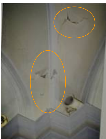
Figura 77 - Forro de estuque da nave central da Catedral. Destaque para as fissuras Local: Nave Central da Catedral acima do coro
