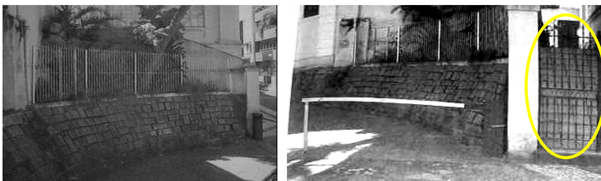
Figura 72 - Imagens do acesso lateral da Catedral. Destaque para a escadaria de acesso a ala administrativa Fonte arquivo Gerência de Patrimônio/FCC
