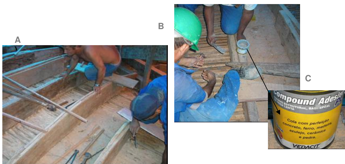
Figura 84- Imagens da colocação dos fios de cobre para fixar o forro de estuque. A) operários removendo as áreas fragilizadas e limpando as sujidades entre os ripamentos do forro de estuque B) operários trabalhando na colocação dos fios de cobre revestido e fixação com resina epóxi C) detalhe do adesivo epóxi utilizado para fixar os fios de cobre junto ao “bolo” Fonte: Acervo da autora-2006
