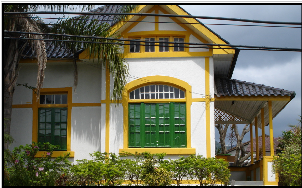
Figura 3: Prédio da antiga Prefeitura Municipal de Itapema. Fonte: Imagem da autora- 15/11/2005.
