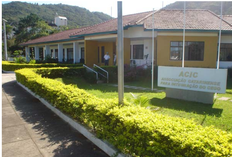
Figura 1. Foto da fachada da Associação Catarinense para Integração do Cego.
