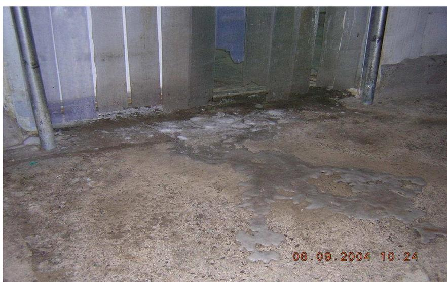
Figura 51: Formação de gelo, os pisos sofrem desgastes acentuados e em grande parte dos processos, com o tempo, acabam se rompendo por penetração de umidade e posterior congelamento.
