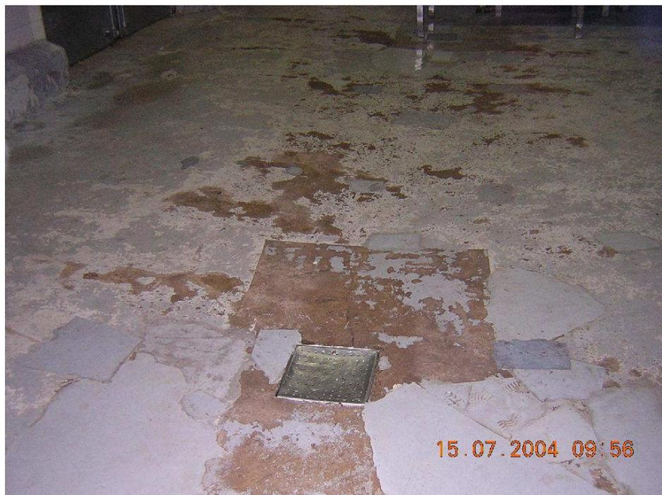
Figura 55: Circulação com desgastes acentuados e formação de buracos, provocados por passagem de empilhadeiras e outros carros de transporte.
