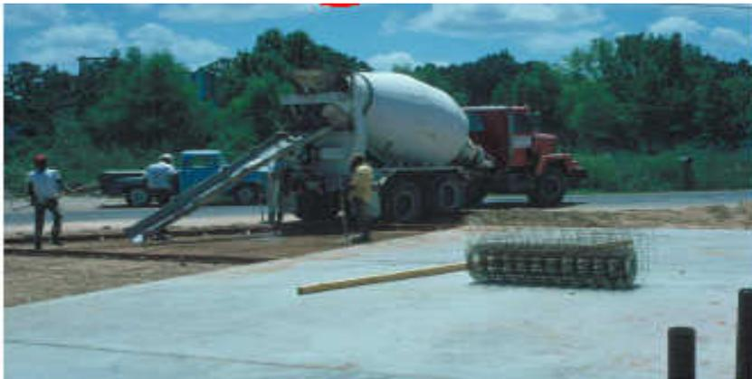
Figura 23: Lançamento do concreto.
