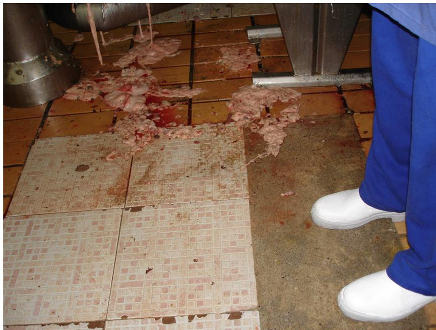
Figura 41: Processo de separação de miúdos, lavação e preparação de tripas e outros pertences internos. Sangue sobre chão, mucosas, ácidos, sal e água quente, provocando desgastes do piso e apodrecimentos do mesmo. Fonte: Acervo pessoal (2006).
