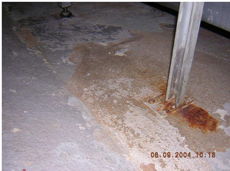
Figura 43: Lavagem de Balancins, ataque ácido provoca desgastes acentuados e apodrecimentos do mesmo.
