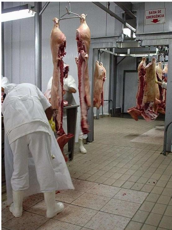
Figura 46: Carcaças de suínos para processamento de cortes com quedas de pedaços de carnes e gorduras, provocando desgastes acentuados, deslocamento de peças cerâmicas e formação de buracos.
