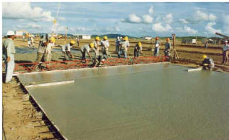
Figura 24: Lançamento do concreto.
