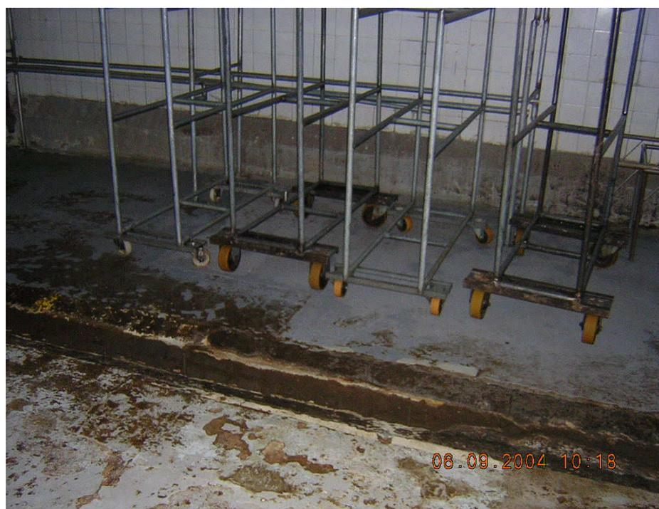
Figura 44: Área de triparia ataque por sal, provocando desgastes acentuados e apodrecimento dos mesmos.
