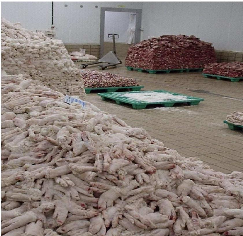
Figura 50: Salgados sobre plataformas e pisos provocam pisos soltos, apodrecimentos da base e corrosão das armaduras da placa do piso.
