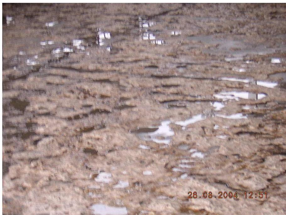
Figura 32: Piso de pocilga atacado por agentes agressivos. Buracos provocados pelos agentes químicos e processos de higienização com água sob pressão.
