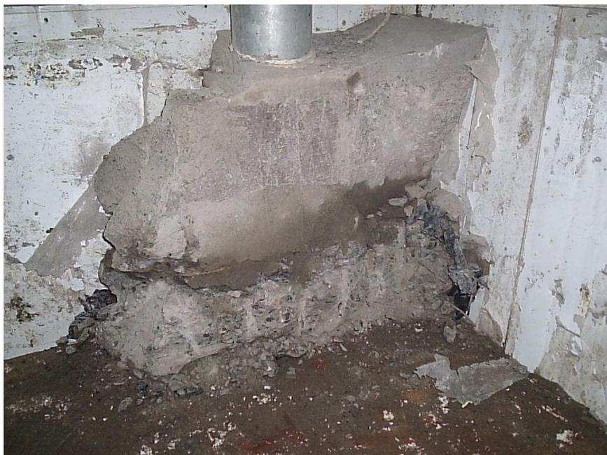
Figura 52: Formação de gelo, pisos com rompimento por penetração de umidade e congelamento da base.
