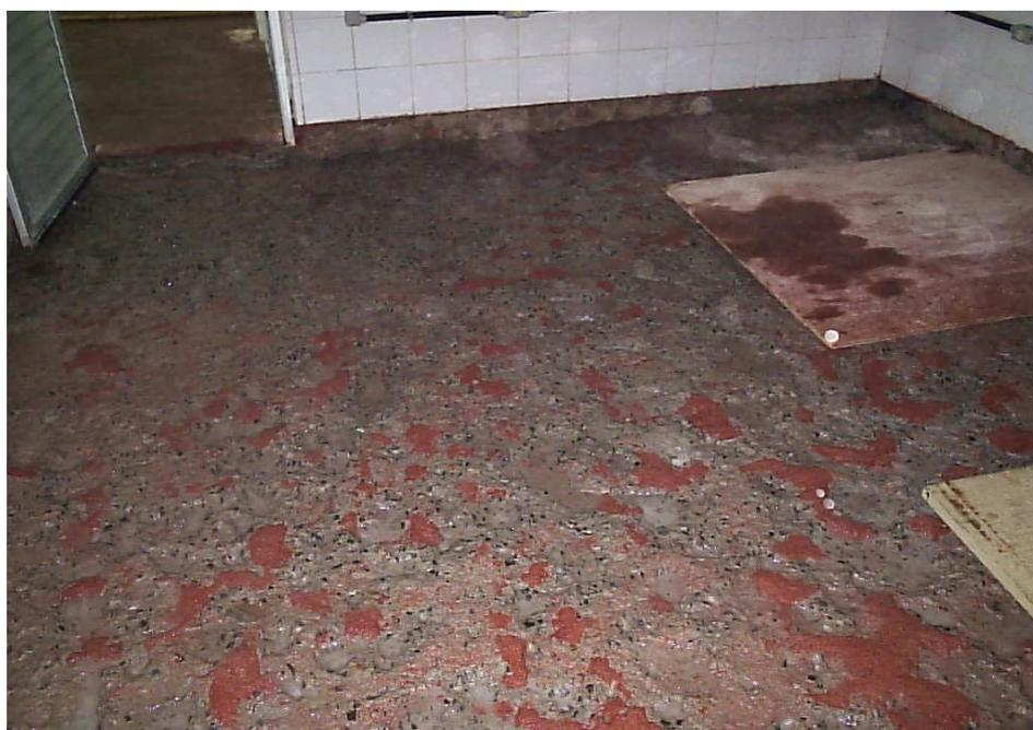
Figura 42: Setor de triparia, área de beneficiamento de tripas. Corrosão da camada superior do piso por ataque de sal e ácidos. Fonte: Acervo pessoal (2005).
