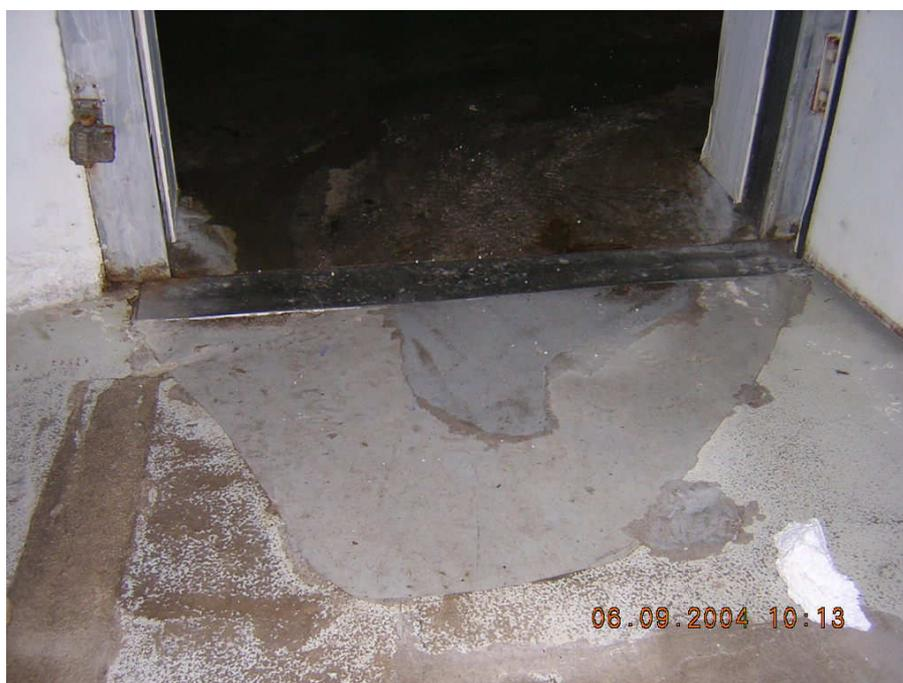
Figura 53: Formação de gelo e desgaste por abrasão próximo às áreas de expedição, através da movimentação de empilhadeiras e outros carros de transporte.
