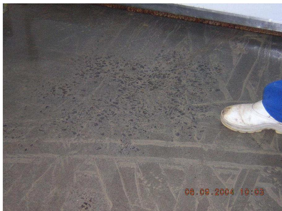
Figura 56: Desgaste por abrasão, provocados pela passagem de rodas das empilhadeiras.
