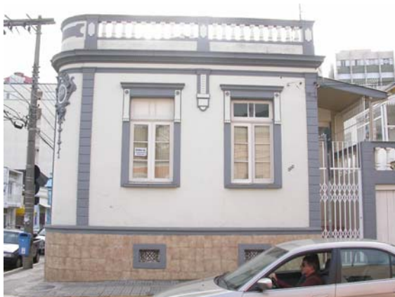
Figura 5. 21 - Fachada de edifício existente na área em estudo
