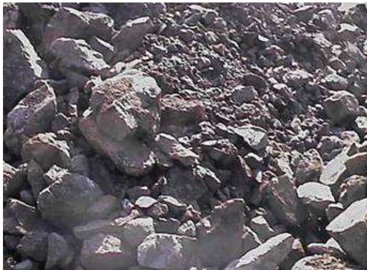
Figura, 3-35 – Enrocamento médio na praça de aplicação.
