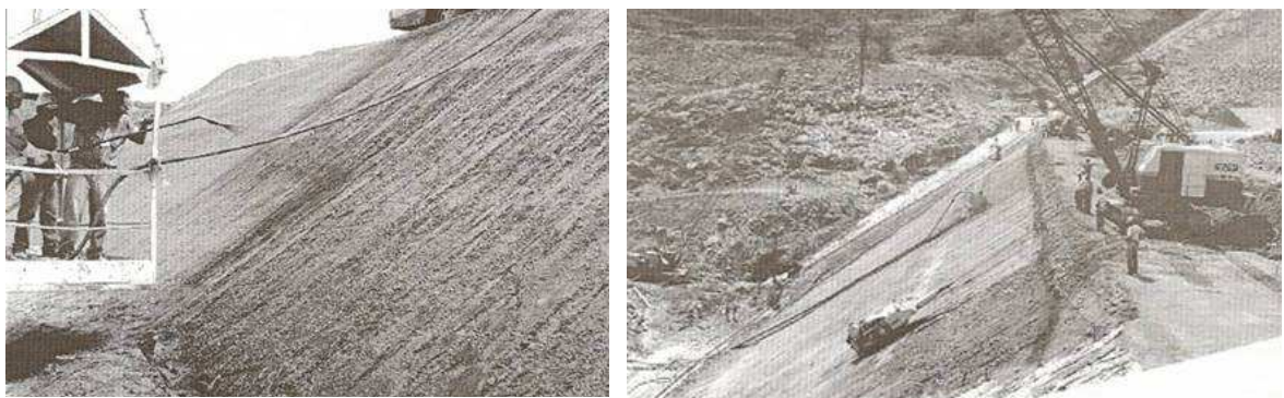
Figura, 3-26 – Imprimação e compactação. Efeito “yô-yô” 4 .
