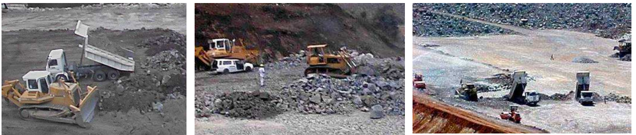
Figura, 3-41 – Lançamento e espalhamento do enrocamento.
