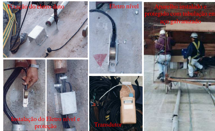
Figura, 4-12 – Eletro Nível – instalação na face laje de vedação.
