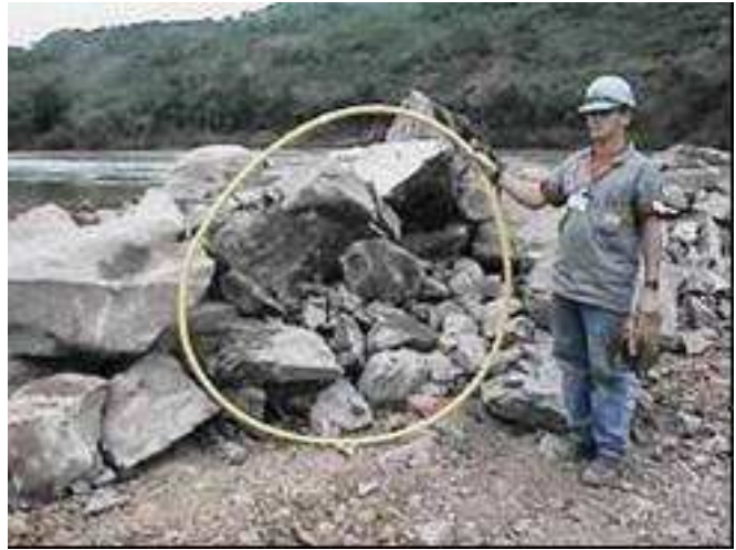
Figura, 3-36 – Enrocamento graúdo duro na praça de aplicação.
