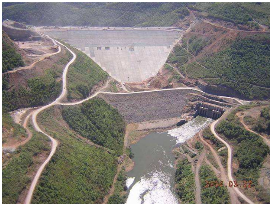
Figura, 1-5 – Barragem de Barra Grande fase de construção – Vista de montante.
