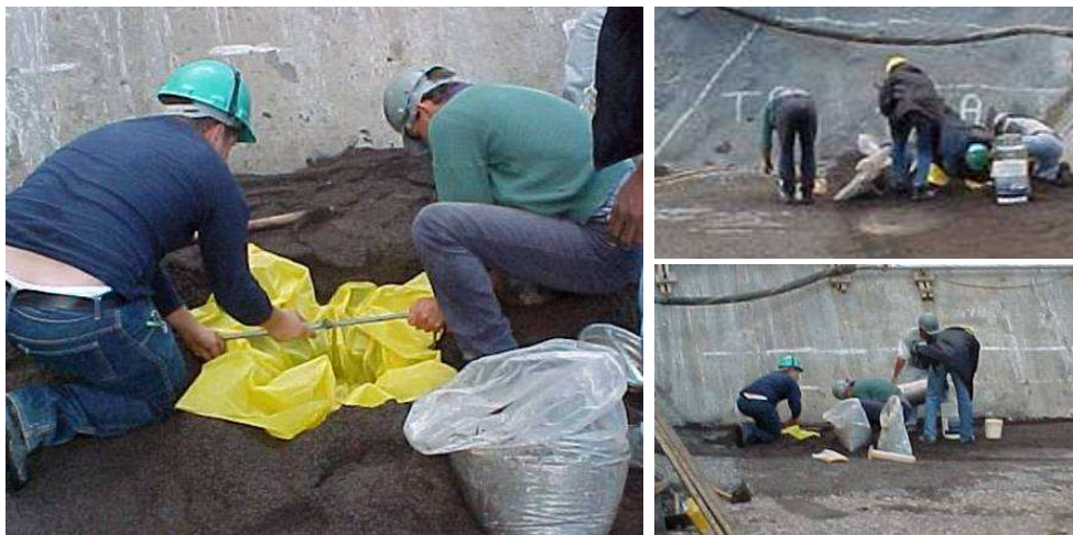
Figura, 3-48 – Ensaio de densidade “in-situ” na transição.
