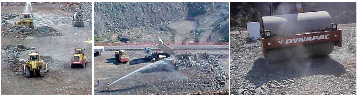
Figura, 3-42 – Molhagem e compactação.
