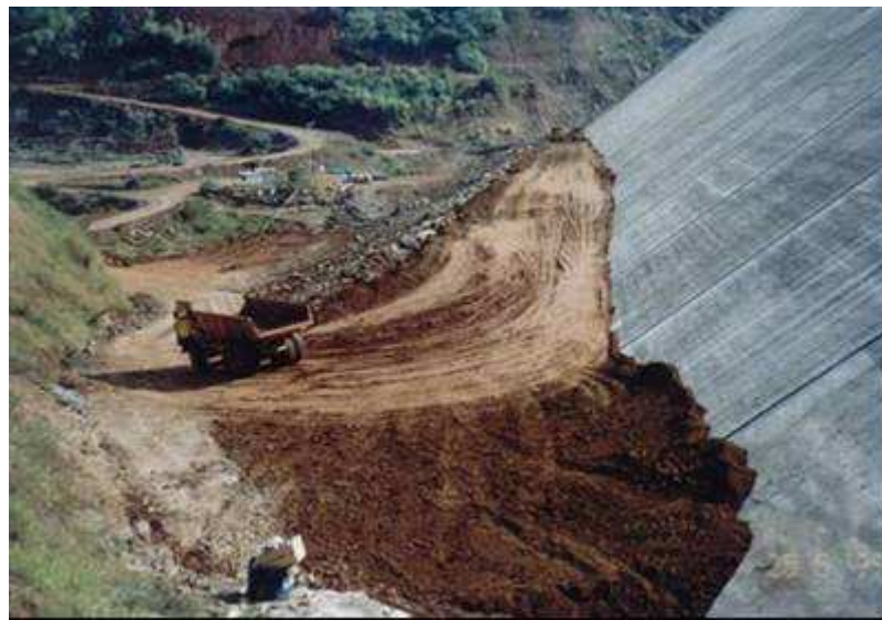
Figura, 3-6 – Detalhes do aterro de proteção na região central executado sobre o plinto.
