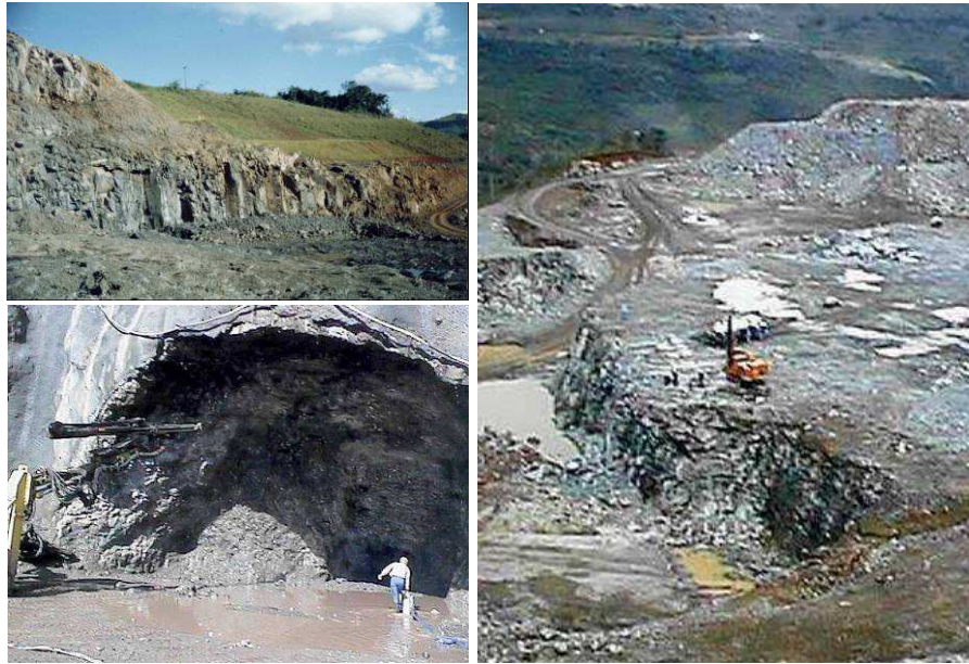
Figura, 3-39 – Escavações obrigatórias, principal fonte de obtenção de enrocamento.
