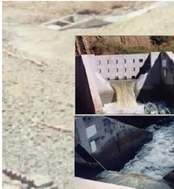
Figura, 4-13 – Medidor de Vazão Triangular.
