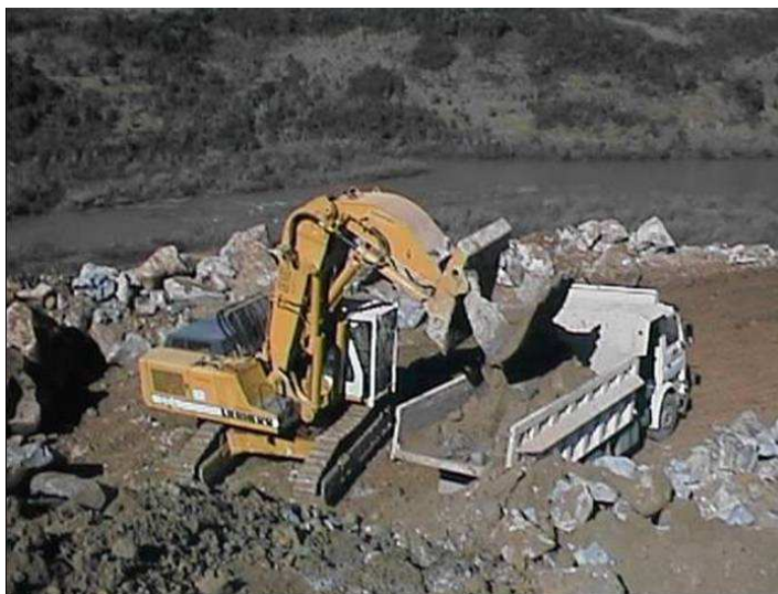
Figura, 3-38 – Enrocamento graúdo brando.
