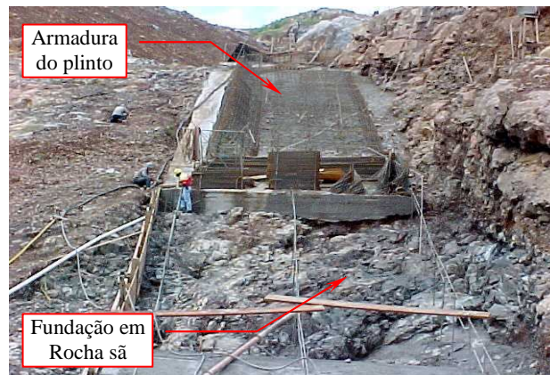
Figura, 3-10 – Preparo da fundação e a ferragem de armação do plinto.
