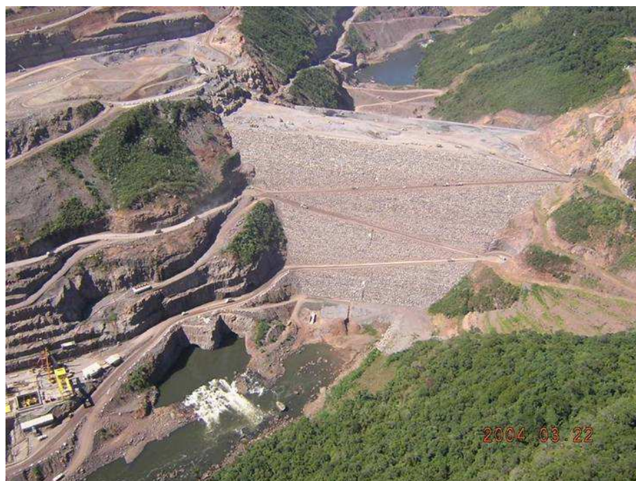
Figura, 1-6 – Barragem de Campos Novos fase de construção – Vista de jusante.
