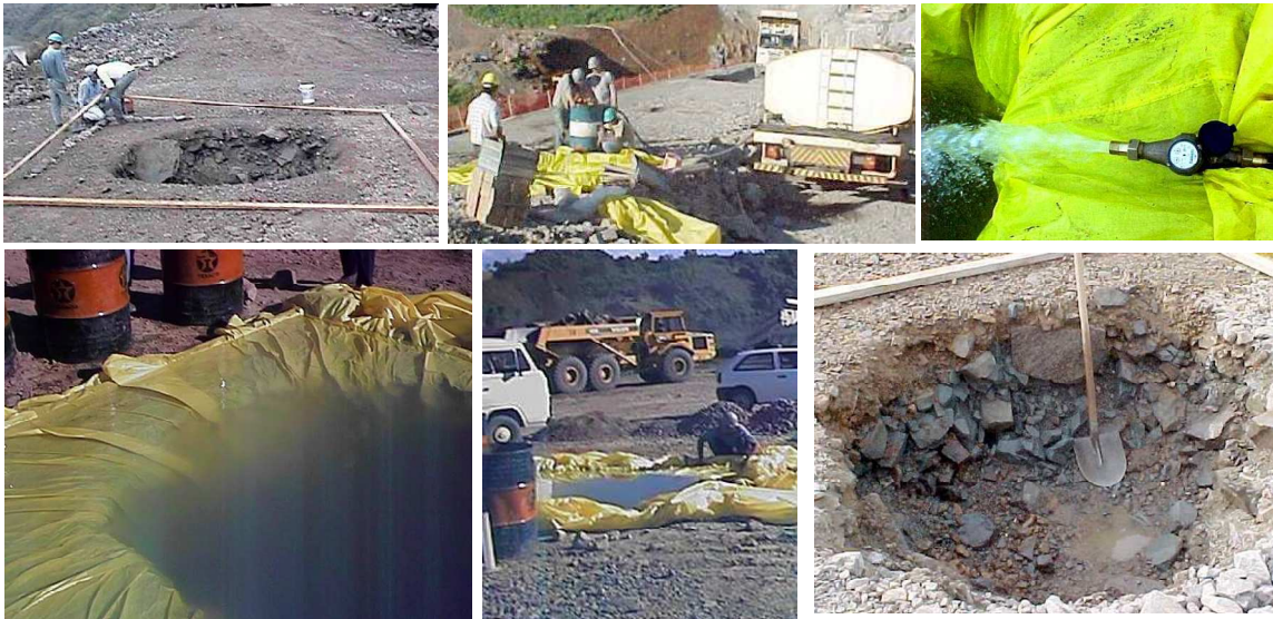
Figura, 3-49 – Realização do ensaio de densidade “in-situ” em enrocamento médio.
