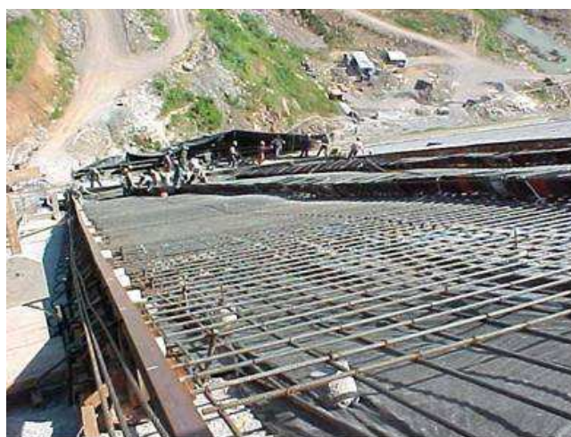
Figura, 3-14 – Trecho superior mostrando o posicionamento central da armadura.
