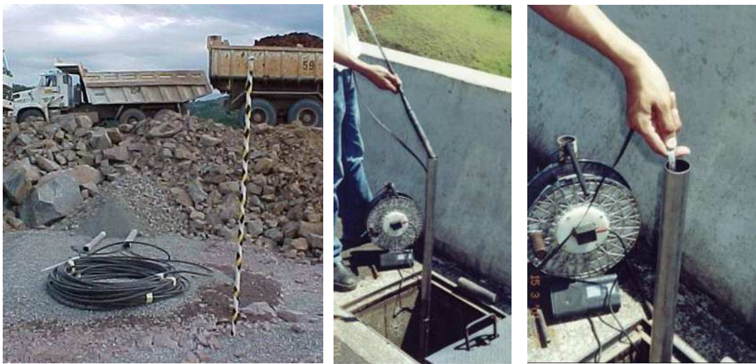
Figura, 4-5 – Medidor de Recalque magnético – Leitura do instrumento.
