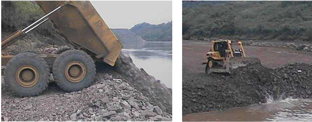
Figura, 3-40 – Lançamento em ponta de aterro.
