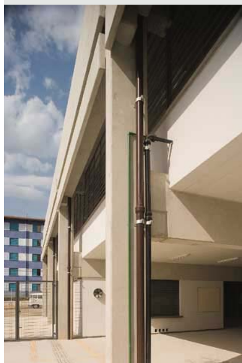
Figura 4.17 Escola construída com elementos de concreto pré-moldado no sistema pilar/viga. Site www.arcoweb.com.br . Acesso em 27 de abril de 2007.
