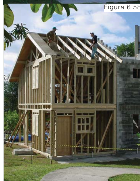
Figura 6.57 a Figura 6.58 Seqüência Construtiva do Protótipo construído no Sistema Plataforma na UFSC. Fonte: GIEM/UFSC, 2003.
