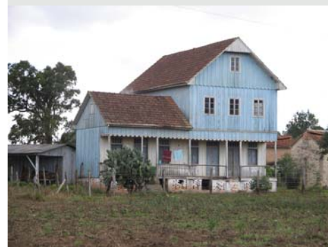
Figura 4.46 Casa em Irenópolis-SC. Foto do autor, 2006.
