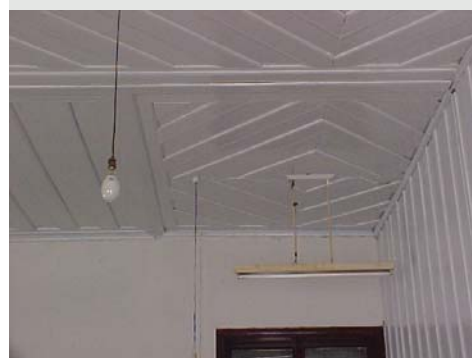
Figura 3.86 Detalhe do forro. Casa mista em Prudentópolis-PR. Foto do autor, 2000.
