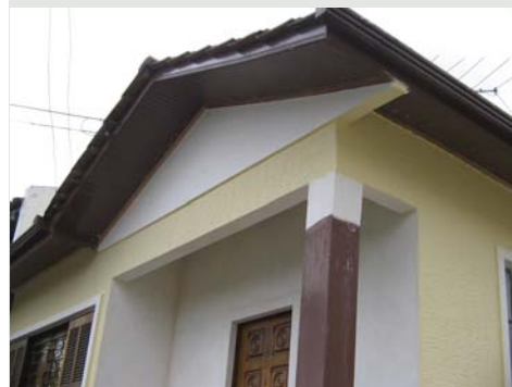
Figura 3.112 Casa revestidas com placas de Erkulit. Foto do autor, 2006.
