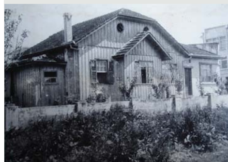
Figura 3.113 Casa antes do revestimento com placas de Erkulit. Fonte: Acervo empresa Erkulit Ind. e Com. LTDA, 1972.
