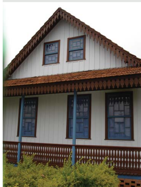
Figura 3.94 Detalhe do guarda corpo da varanda. Casa remontada no Campus da PUC em São José Pinhais -PR. Foto do autor, 2005.
