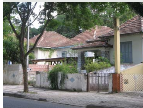
Figura 3.61 Casa tipo quatro águas em série. Rua Júlia Wanderley em Curitiba-PR Foto do autor, 2006.
