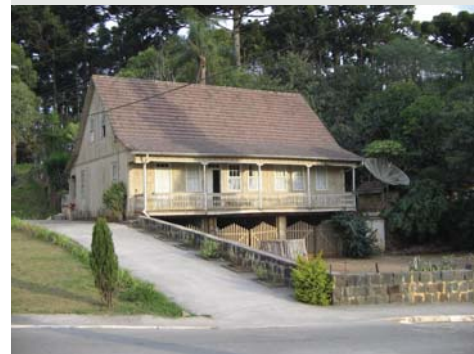
Figura 3.76 Detalhe do aproveitamento do vão entre o solo e o piso da casa como porão. Rio Branco do Sul-PR. Foto do autor, 2006.
