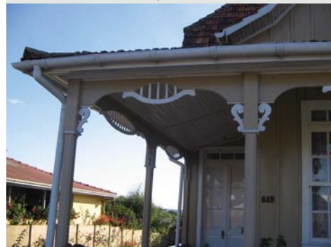
Figura 4.33 Detalhe da varanda. Casa em São Mateus do Sul-PR. Foto do autor, 2006.
