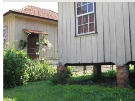
Figura 3.73 Detalhe do pilarete de fundação em alvenaria. Rua Pe. Anchieta em Curitiba-PR. Foto do autor, 2006.
