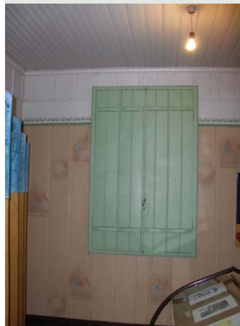
Figura 3.82 Detalhe do janela na parede de tábua e mata-juntas. Casa Erbo Stenzel, parque São Lourenço, Curitiba-PR. Foto do autor, 2005.
