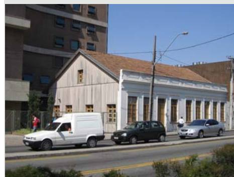
Figura 3.17 Casa de madeira com frente em alvenaria nas imediações da área central em Curitiba-PR (Rua Marechal Floriano) Foto do autor, 2006.
