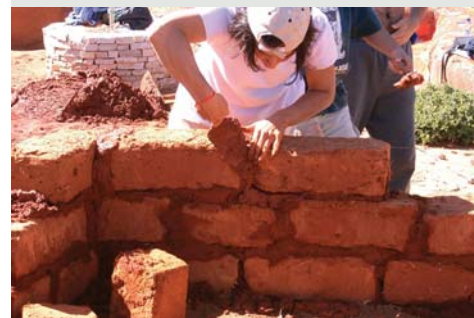
Figura 4.43 Mutirão para construção em adobe. Site www.ecocentro.org . Acesso em 27 de abril de 2007.
