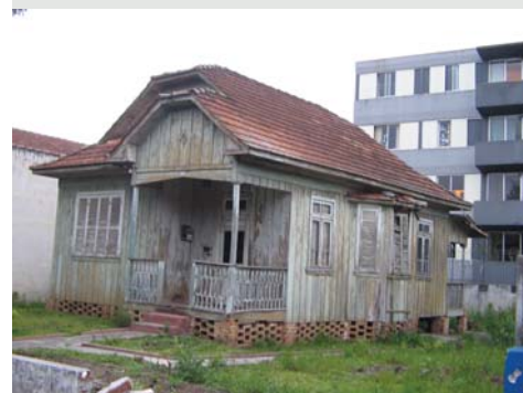
Figura 3.75 Detalhe do fechamento do vão entre o solo e o piso da casa em cobogó de tijolos. Rua Itupava em Curitiba-PR. Foto do autor, 2006.
