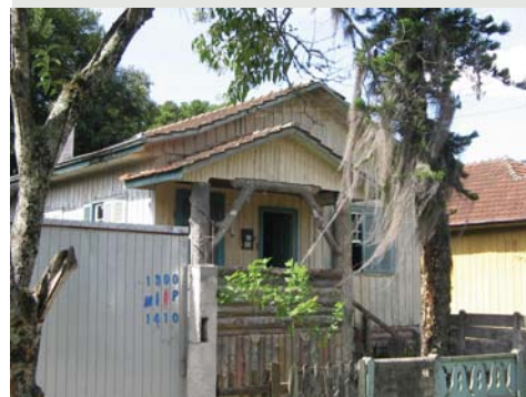
Figura 1.28 Casa Rua Pnta. Luís Thomaszeck, em Curitiba-PR. Foto do autor, 2007.
