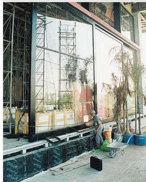
Figura 4.21 Montagem esquadria de alumínio. Site www.arcoweb.com.br . Acesso em 27 de abril de 2007.
