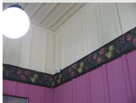
Figura 3.95 Detalhe das pinturas da parede. Casa Domingos Nascimento Sede do IPHAN-PR Foto do autor, 2007.
