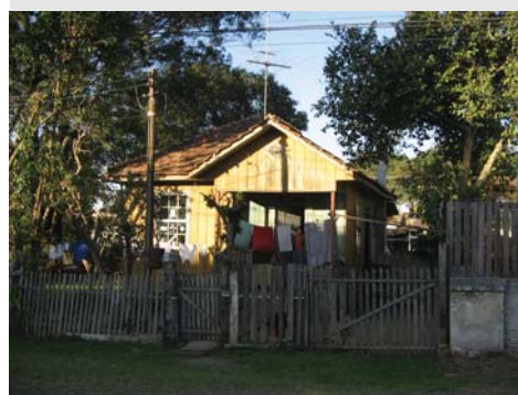
Figura 5.90 Casa provavelmente Tipo "C" com telhado de quatro águas. Detalhe do oitão com pequena janela em losango. Vila Colorado em Curitiba-PR. Foto do autor, 2006.
