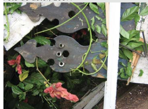
Figura 3.71 Detalhe do lambrequim de uma Casa de Araucária do início do século XX sendo demolida. Rua Trajano Reis em Curitiba-PR. Foto do autor, 2007.
