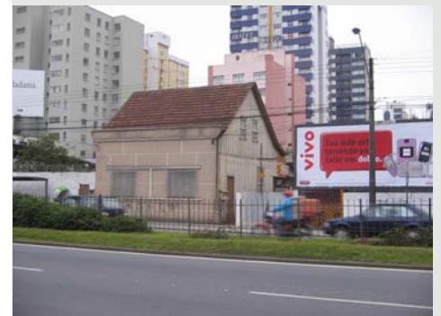
Figura 3.20 Casa de madeira com frente em alvenaria nas imediações da área central em Curitiba-PR (Rua Francisco Torres) Foto do autor, 2006.
