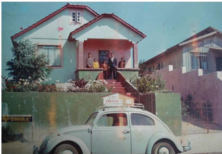
Figura 3.117 Casa revestida com placas de Erkulit. Fonte: Acervo empresa Erkulit Ind. e Com. LTDA, 1972.
