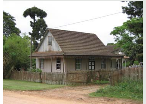
Figura 3.47 Casa de tábuas e mata-juntas. Colônia Muricy em São José dos Pinhais-PR. Foto do autor, 2006.
