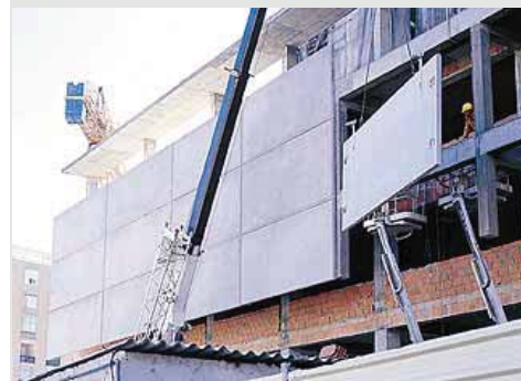
Figura 4.7 Colocação de painel GRFC (painel de concreto reforçado com fibra de vidro). Site www.arcoweb.com.br . Acesso em 27 de abril de 2007.
