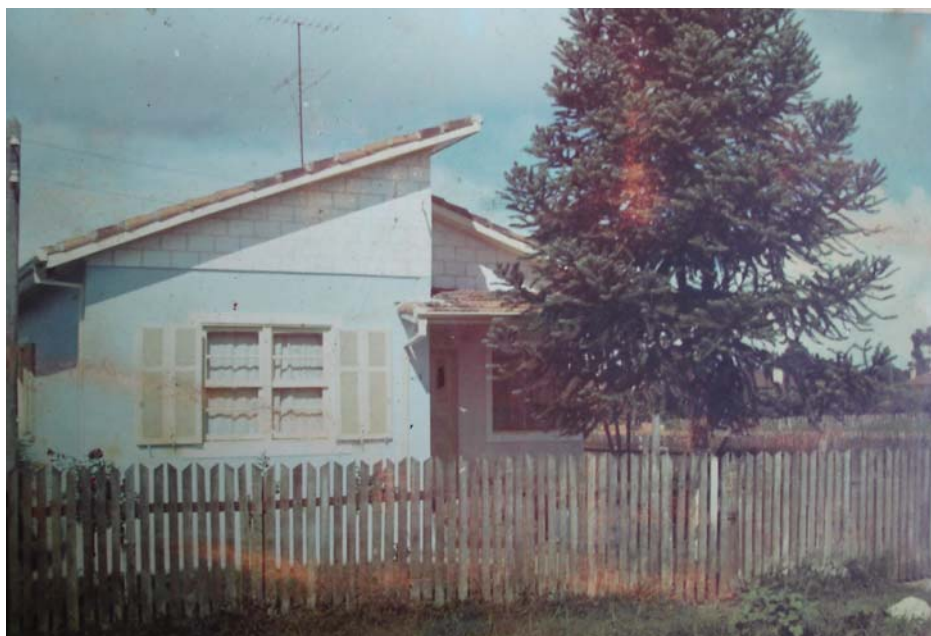
Figura 3.118 Casa revestida com placas de Erkulit. Fonte: Acervo empresa Erkulit Ind. e Com. LTDA, 1972.
