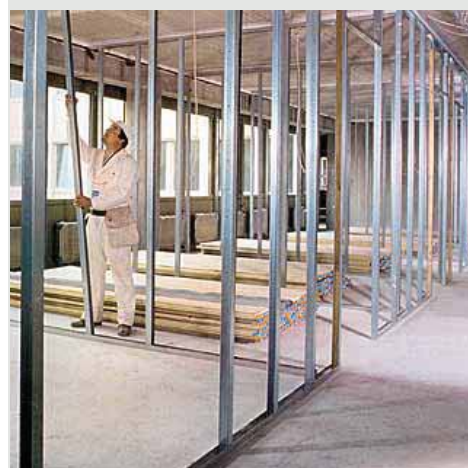
Figura 4.19 Montagem de paredes internas com placas de gesso acartonado. Site www.arcoweb.com.br . Acesso em 27 de abril de 2007.
