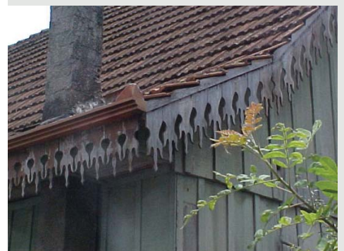
Figura 2.8 Detalhe dos lambrequins cujas funções são proteger os caibros e servir como pingadeira protegendo as paredes das interpéries. Por possuir muita plasticidades este elemento foi sendo reproduzido e alterado apresentando grande variação de desenhos e formas. Sua função é quase que esquecida tornando-se um elemento estético. Casa em Irati-PR. Foto de Jussara Valentini, 2007.
