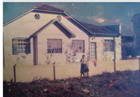
Figura 3.114 Casa revestida com placas de Erkulit. Fonte: Acervo empresa Erkulit Ind. e Com. LTDA, 1972.
