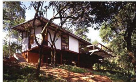
Figura 4.6 Casa Flávia e Osmar Valentim em Carapicuíba, SP Projeto do UNA Arquitetos e construído pela ITA Engenharia em 1999. Site www.itaconstrutora.com.br . Acesso em 27 de abril de 2007.
