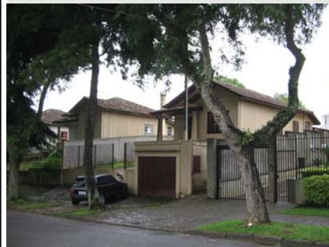
Figura 3.59 Casa tipo chalé em série. Rua Guaratuba em Curitiba-PR. Foto do autor, 2007.
