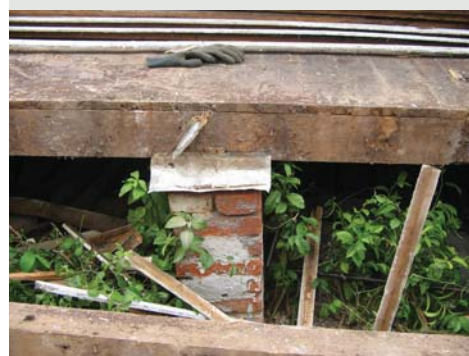
Figura 3.83 Detalhe do encaixe macho e fêmea da tábua do piso. Casa sendo demolida, Rua Trajano Reis em Curitiba-PR. Foto do autor, 2006
