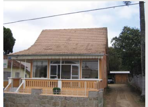
Figura 2.10 Detalhe das janelas substituída por panos de vidro. Casa Rua Manoel Ribas em Curitiba-PR. Foto do autor, 2006.
