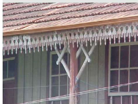
Figura 4.34 Detalhe da varanda. Casa em Irati-PR. Foto de Jussara Valentini, 2007.
