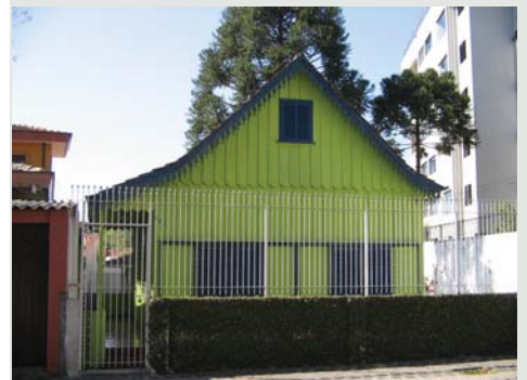
Figura 3.24 Casa Rua 21 de Abril em Curitiba-PR. Foto do autor, 2006.
