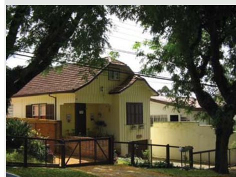
Figura 1.20 Casa Rua Pe. Francisco Aulling, em Curitiba-PR. Foto do autor, 2006.
