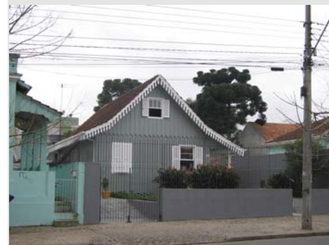
Figura 3.14 Casa de madeira no bairro Vila Isabel em Curitiba-PR, com a mesma volumetria da figura 3.13, porém com as proporções menores Foto do autor, 2006.
