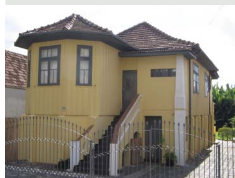
Figura 3.98 Detalhe do preenchimento em alvenaria provavelmente para inclusão de banheiro. Casa Rua Solimões em Curitiba-PR. Foto do autor, 2006.
