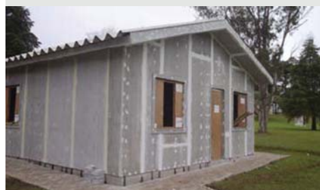
Figura 4.20 Casa construída com painéis de chapa cimentícia. Site www.eternit.com.br . Acesso em 27 de abril de 2007.
