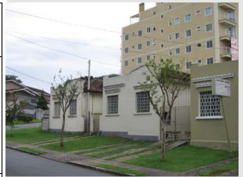
Figura 3.67 Casa mista com telhado em quatro águas em série. Rua Colombo em Curitiba-PR. Foto do autor, 2007.
