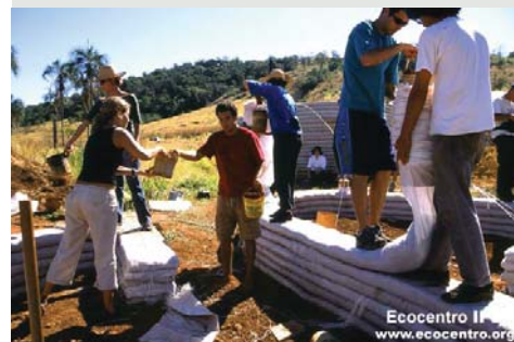
Figura 4.44 Mutirão para construção em super-adobe. Site www.ecocentro.org . Acesso em 27 de abril de 2007.
