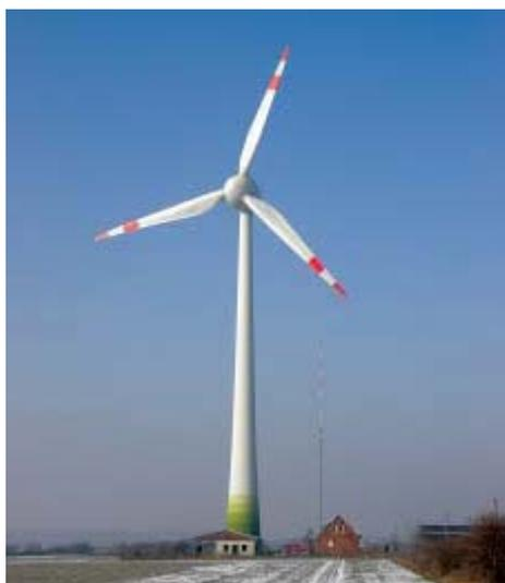
*Figura 2.1 - Turbina eólica de alta potência – Enercon E112 com potência de 4,5 MW e diâmetro de 112 m.*
