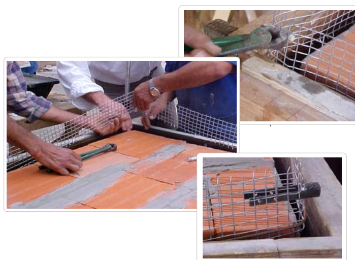
Figura 68 – Detalhe do inserte metálico junto à tela soldada galvanizada
