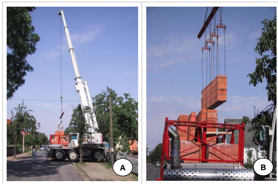
Figura 3 – (a) e (b) – Movimentação de painel por meio de guindaste móvel.
