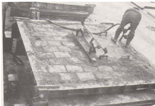
Figura 8 – Moldagem do painel em fôrma basculante (REVEL, 1973).
