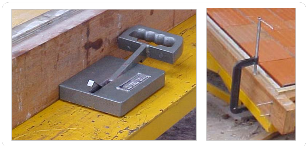
Figura 64 – Tipo de fixadores usados nos painéis
