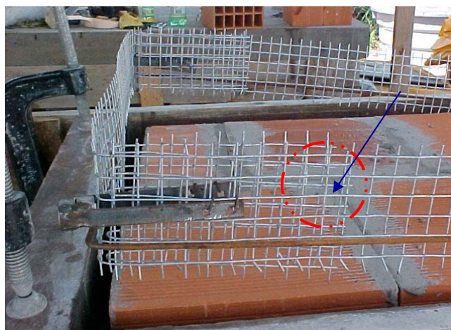
Figura 47 – Armadura discreta componente do painel
