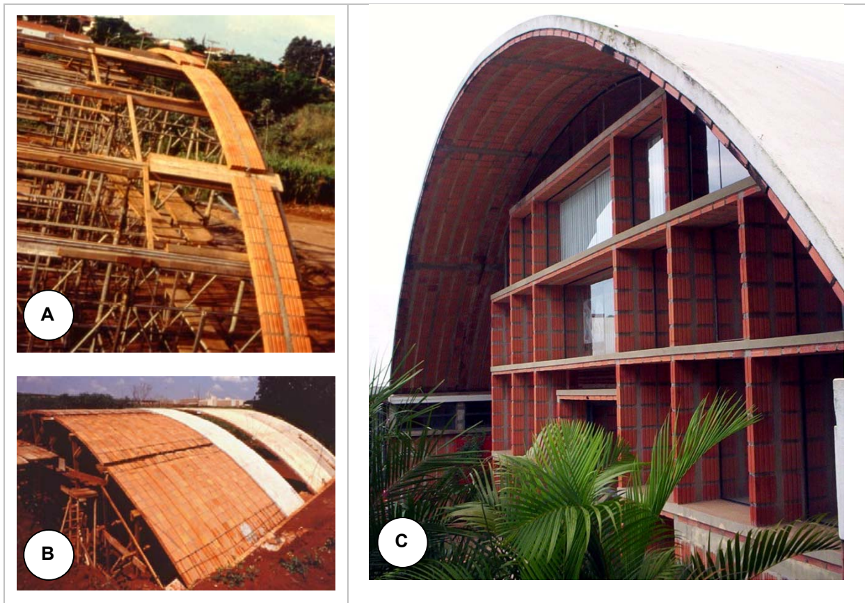
Figura 16 – ( A ) e ( B )Etapas da montagem e ( C ) Casa do Lago (UNICAMP) concluída (Sarrablo,2001)
