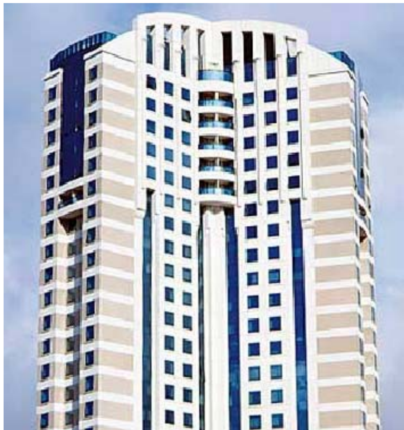
Figura 1- Fachadas em painéis pré-fabricados arquitetônicos de concreto (Edifício Blue Tree Tower – Morumbi) (OLIVEIRA, 2002).
