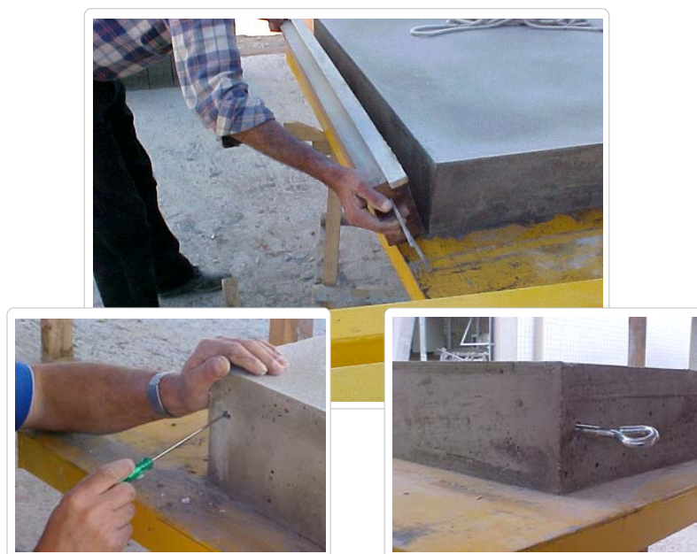
Figura 70 – Desmoldagem e procedimento para içamento
