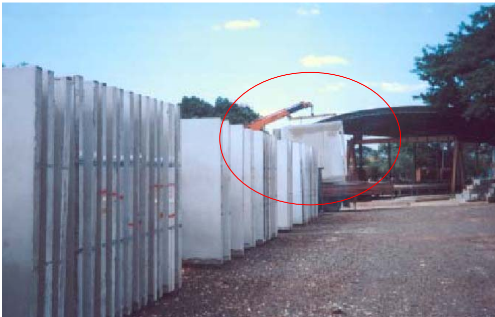
Figura 15 – Painéis pré-fabricados sendo içados do local de armazenamento (IPT,2003)
