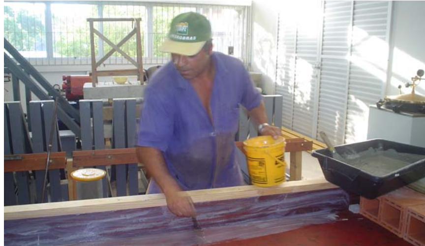
Figura 65 – Aplicação do desmoldante
