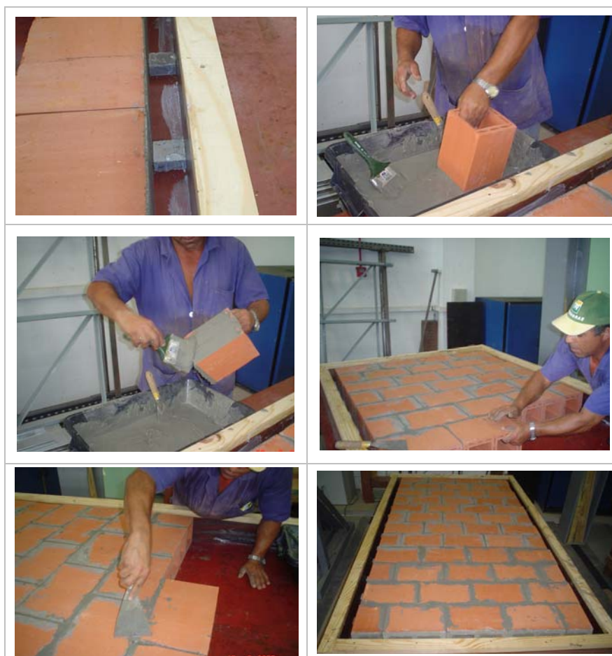
Figura 67 –Espaçadores para reforço perimetral e seqüência do assentamento dos blocos
