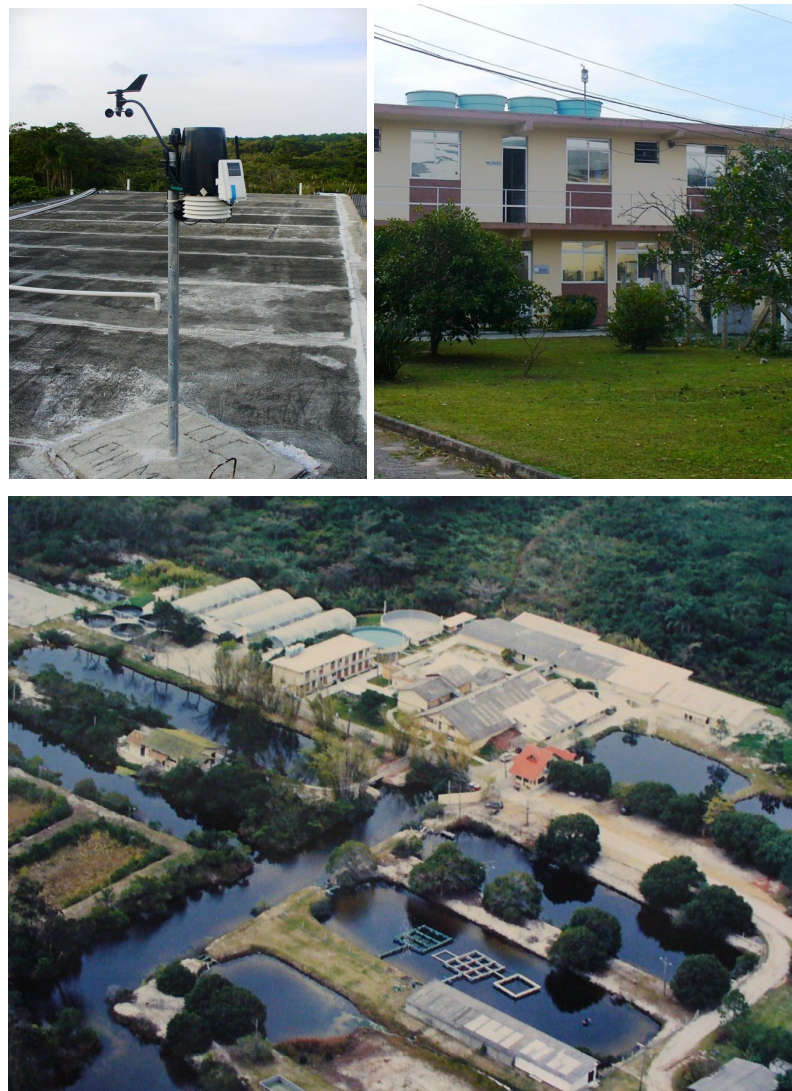
FIGURA 15 – Estação meteorológica do LAHIMAR; Fachada do prédio do Laboratório de Camarões Marinhos – LCM – sobre o qual está instalada a estação meteorológica; vista aérea da Estação de Maricultura da Barra da Lagoa da UFSC.
