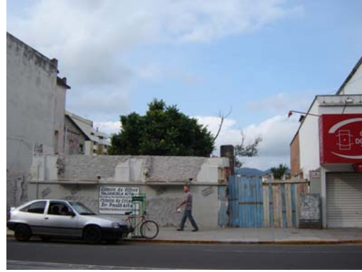
Figura 42. Mesma edificação demolida, Abril 2007. Fotografia: Vanessa Casarin.
