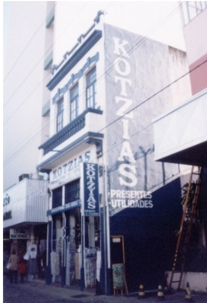
Figura 10: Rua Conselheiro Mafra, 210. 1999. Fonte: IPUF, Projeto Renovar. Identificação e catalogação dos problemas identificados no local.
