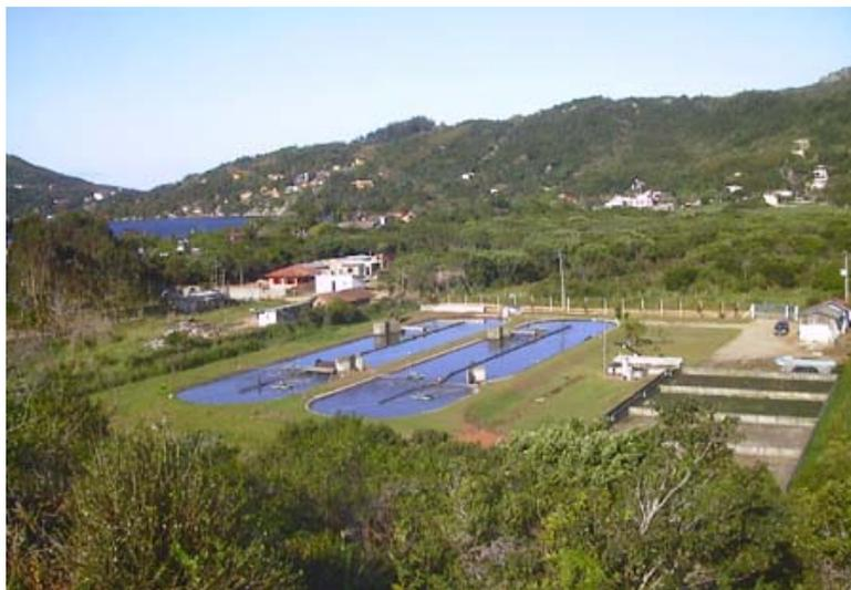
**Figura 7:** Valo de Oxidação. Sistema de tratamento de esgotos da Lagoa de Conceição – Florianópolis
