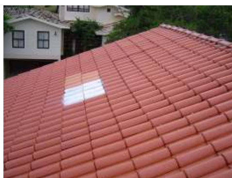
Ilustração 19 - Vista do telhado
