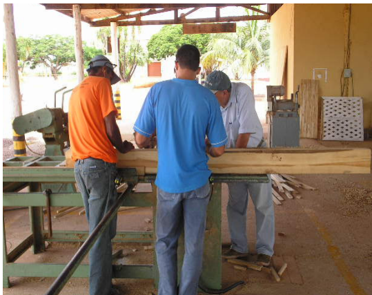
Figura 57 – Preparação das toras para desdobro
