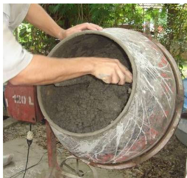
Figura 30 – Concreto em fase de produção na betoneira de eixo inclinado.
