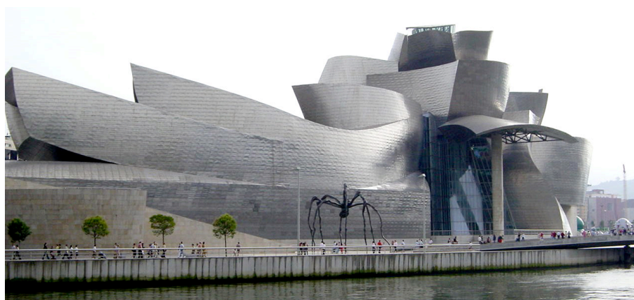
Figura 8: O Museu Guggenheim de Bilbao foi possível de ser realizado graças ao uso de um programa de computador que auxiliou o projeto estrutural e no planejamento de custos. 12
