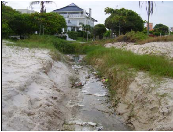
FIGURA 8: Drenagem pluvial da praia de Jurerê Internacional
