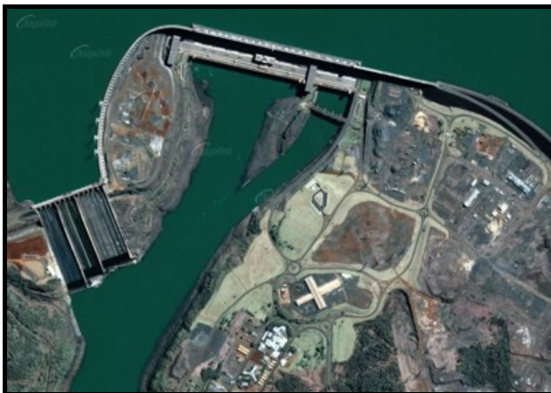
FIGURA 21: Imagem do satélite IKONOS - Hidrelétrica de Itaipu.
