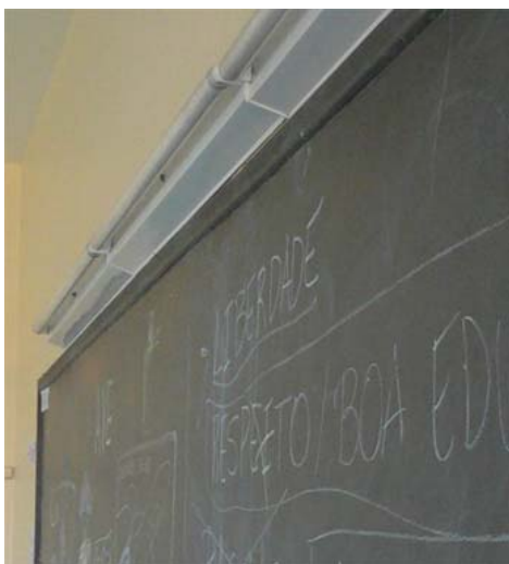
Figura 3.13 – Luminárias existentes localizadas para quadro negro.
