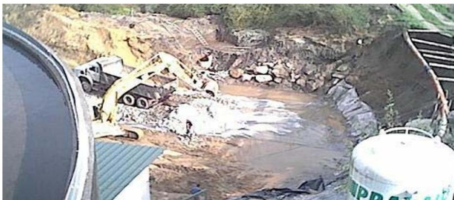
Figura 5.147 – Construção do tanque biológico e decantador – IPM-15
