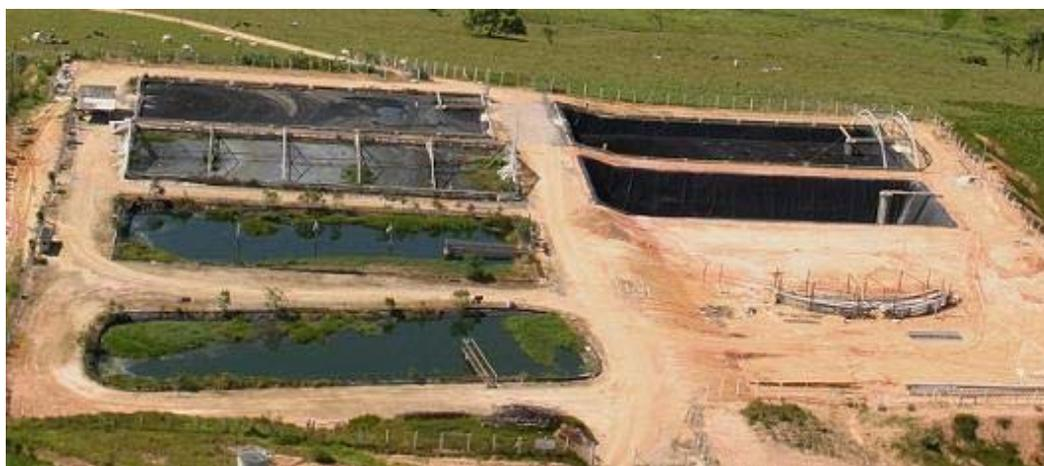
Figura 5.62 – Lagoas de disposição de lodo têxtil – aterro industrial – IBB-07
