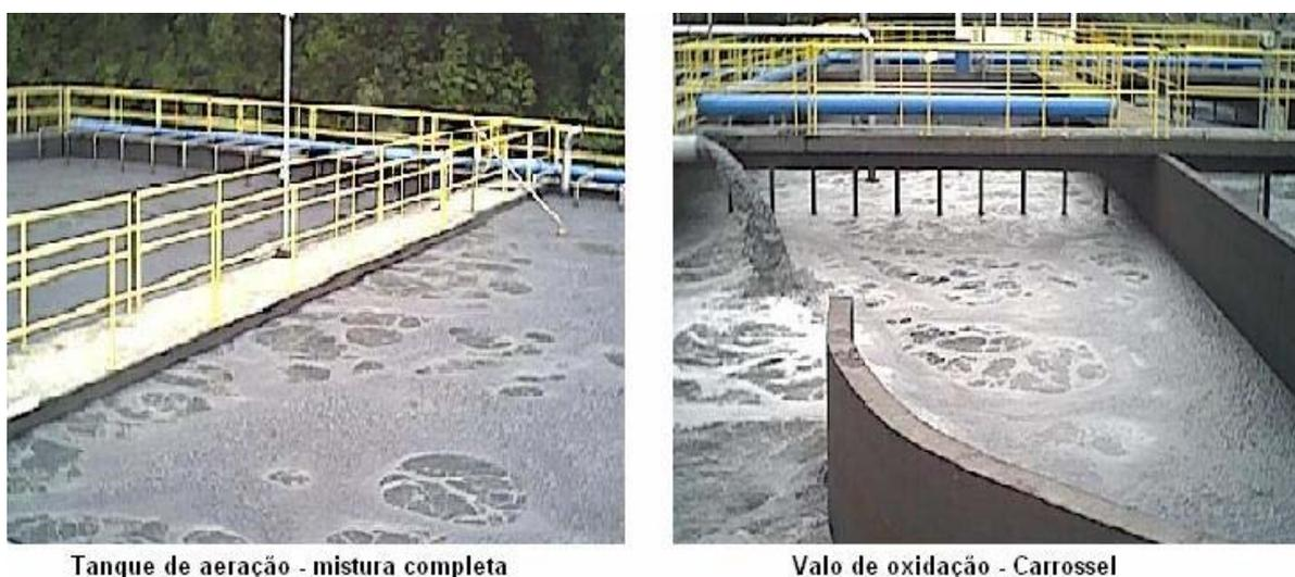
Figura 5.51 – Comparação visual dos dois tanques de aeração da IBB-05.
