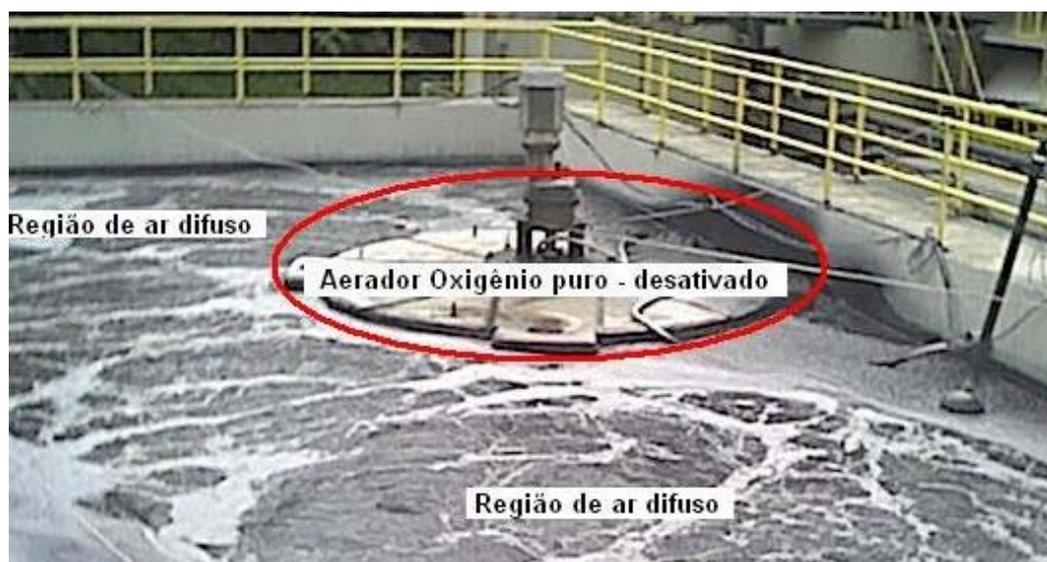
Figura 5.57 – Forma de aeração do tanque biológico da IBB-06.
