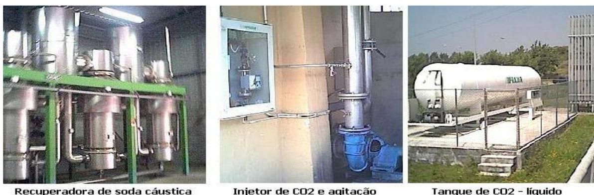
Figura 5.139 – Recuperação de soda cáustica e neutralização com CO<sub>2</sub> puro.
