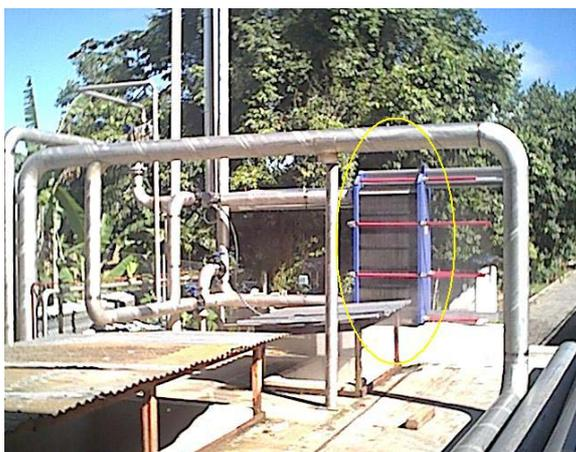
Figura 2.60 – Trocador de calor - placa
