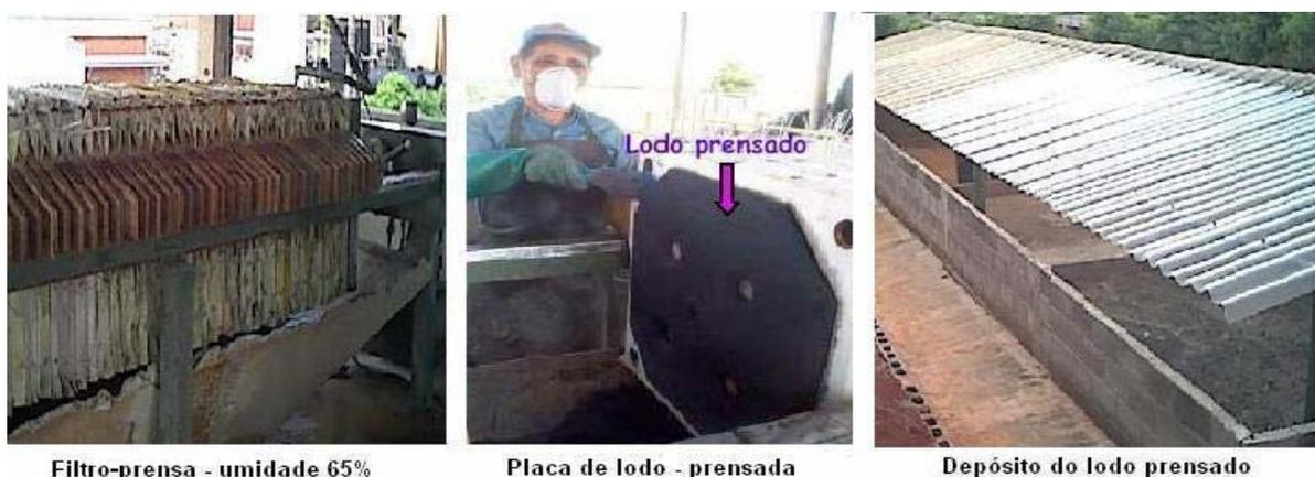
Figura 5.22 – Filtro-prensa, lodo prensado e leito de secagem (coberto)
