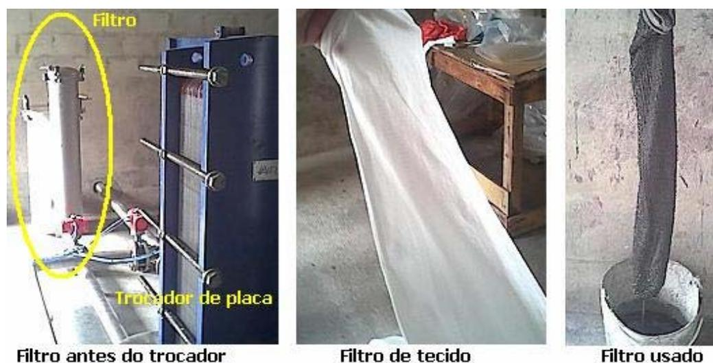
Figura 5.123 – Filtro de proteção do trocador de placa da IPM-09
