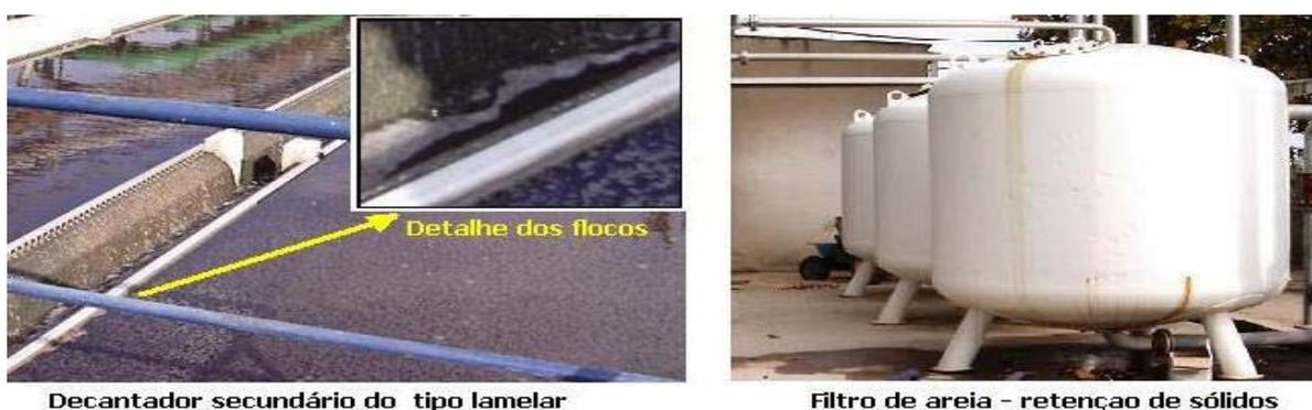
Figura 5.163 – Decantador lamelar e os filtros de areia da IEB-01
