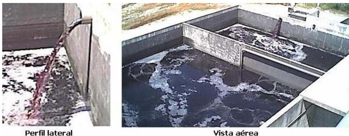
Figura 5.131 – Tanque de homogeneização – efluente colorido e sem agitação
