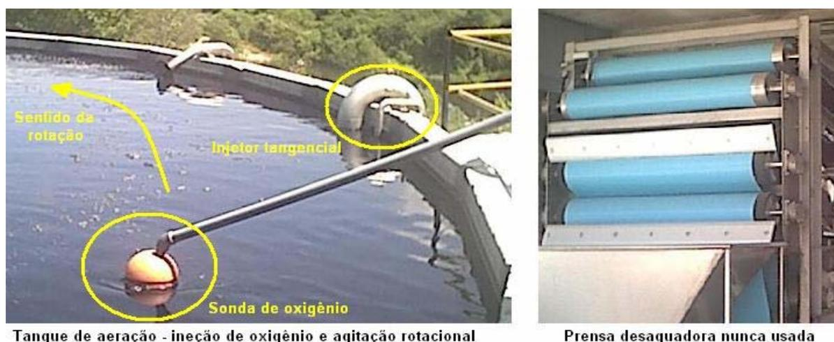
Figura 5.88 – Tanque biológico e prensa desaguadora do STET da IPM-02.
