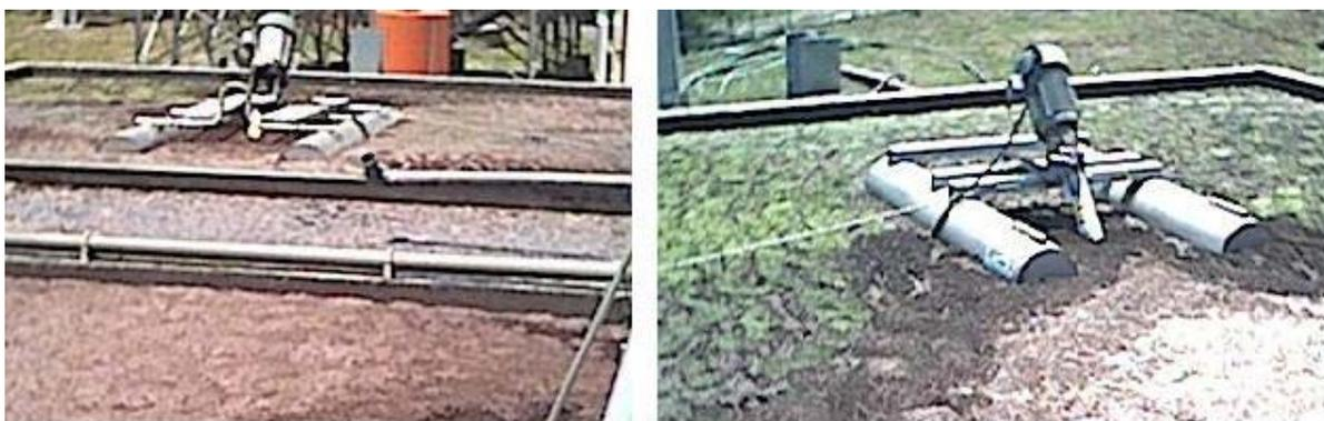
Tanque biológico (aerador desligado) - detalhe da camada de lodo sobre a superfície do tanque
