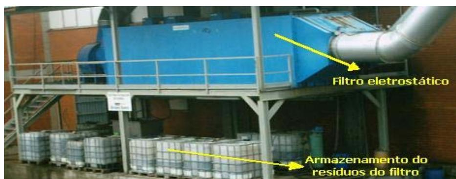
Figura 5.176 – Filtro eletrostático do STET da IEB-03.
