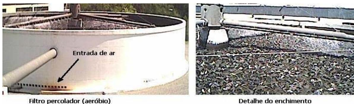
Figura 5.109 – Vista do filtro aeróbio percolador – aeração natural - IPM – 06
