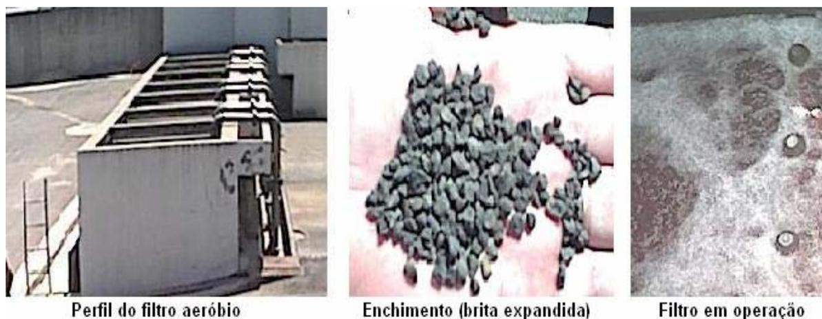
Figura 5.85 – Filtro aeróbio percolador do STET da IPM-01.
