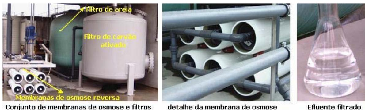
Figura 5.174 – Conjunto de membranas de osmose reversa do STET da IEB-03.
