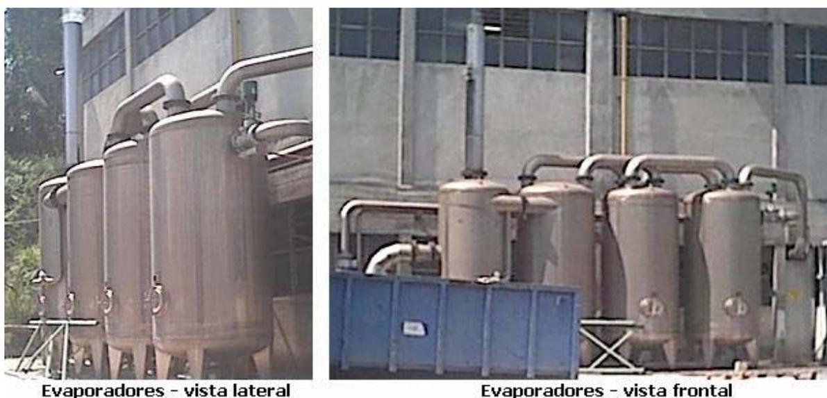
Figura 5.126 – Equipamento de recuperação de soda cáustica na IPM-10
