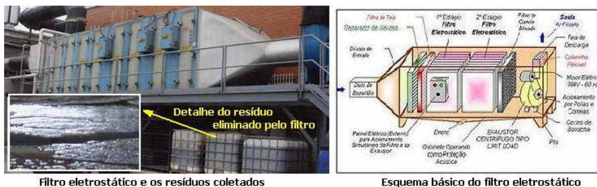
Figura 5.169 – Filtro eletrostático da IEB-02
