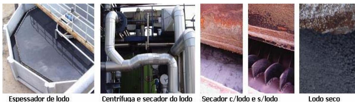
Figura 5.162 – Sistema de desidração do lodo da IEB - 01.
