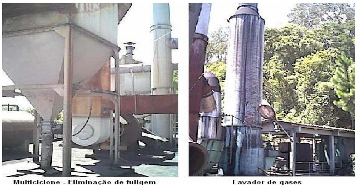
Figura 5.47 – Multiciclone e lavador de gases da IBB-04.
