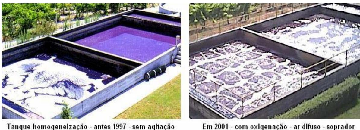
Figura 5.117 – Tanque de homogeneização com pré-oxigenação
