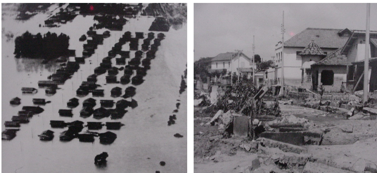
FIGURA 83. Enchente no município de Tubarão em 1974 (PMT, 1999).
