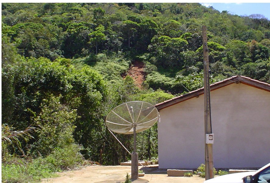
FIGURA 89. Instabilização de taludes no bairro Quilômetro Sessenta.
