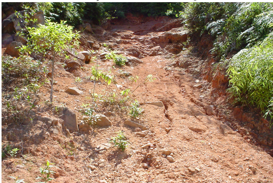
FIGURA 90. Detalhe da instabilização de taludes no bairro Quilômetro Sessenta.
